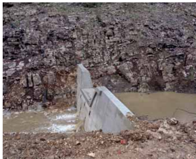
Pregrada na Sitanskom potoku. Foto: Milenko Jakovina, građ. teh.
