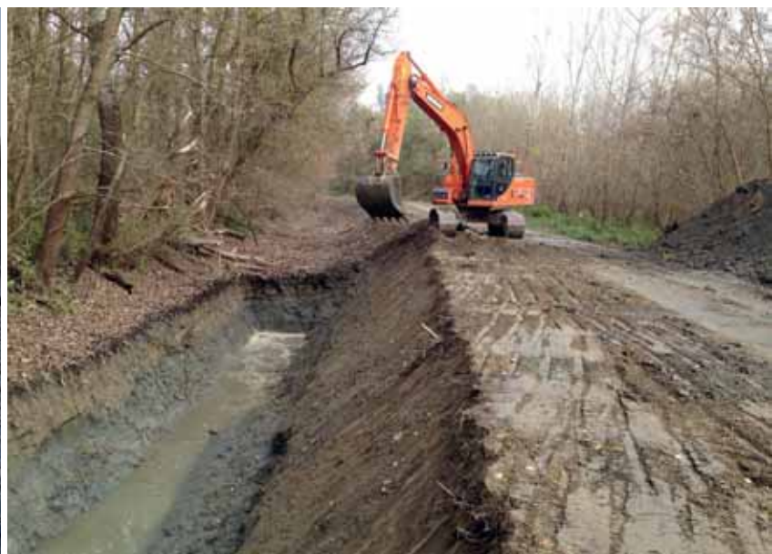
Realizacija 1 faze – produbljivanje kanala
