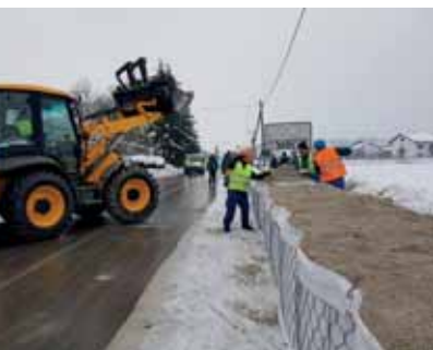
Postavljanje box-barijera u Karlovcu
