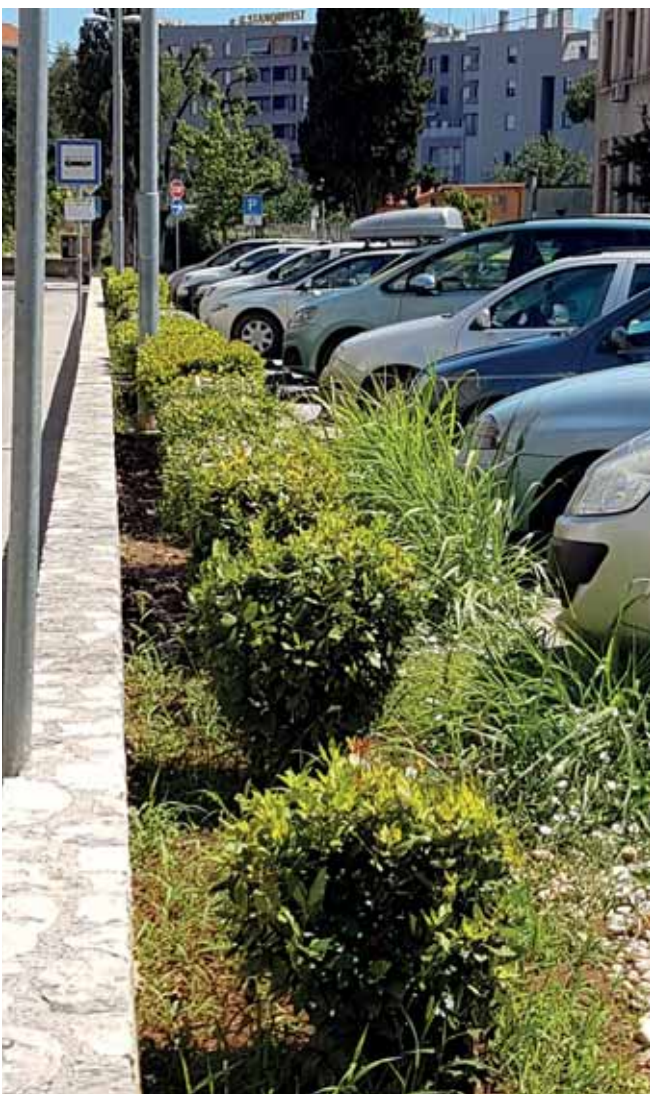
Retencijski park i infiltracijski jarak uz parkiralište u Nazorovoj ulici, Pula. izvor: Tatjana Uzelac
