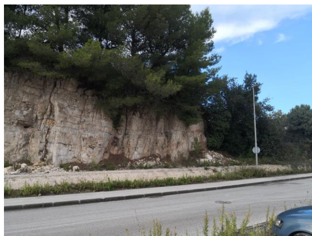
Slika 16. dio stijene iznad spojne ceste
