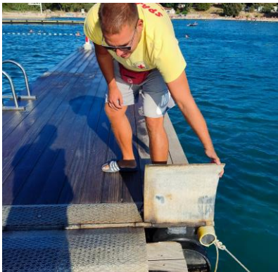
Slika 5: spoj pontona i betonskog mola
