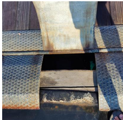
Slika 6: neadekvatni spoj
