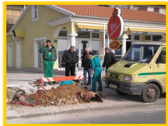
SLIKA: Rekonstrukcija priključka na kanalizaciju
