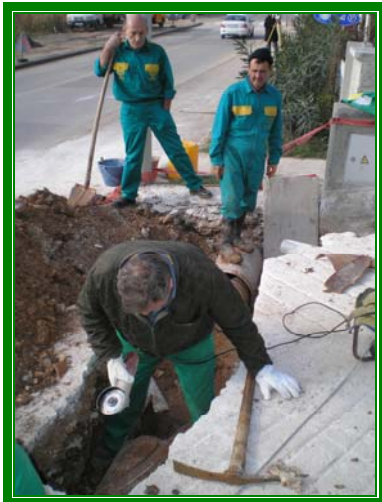
SLIKA: Popravak razbijene kanalizacijske cijevi
