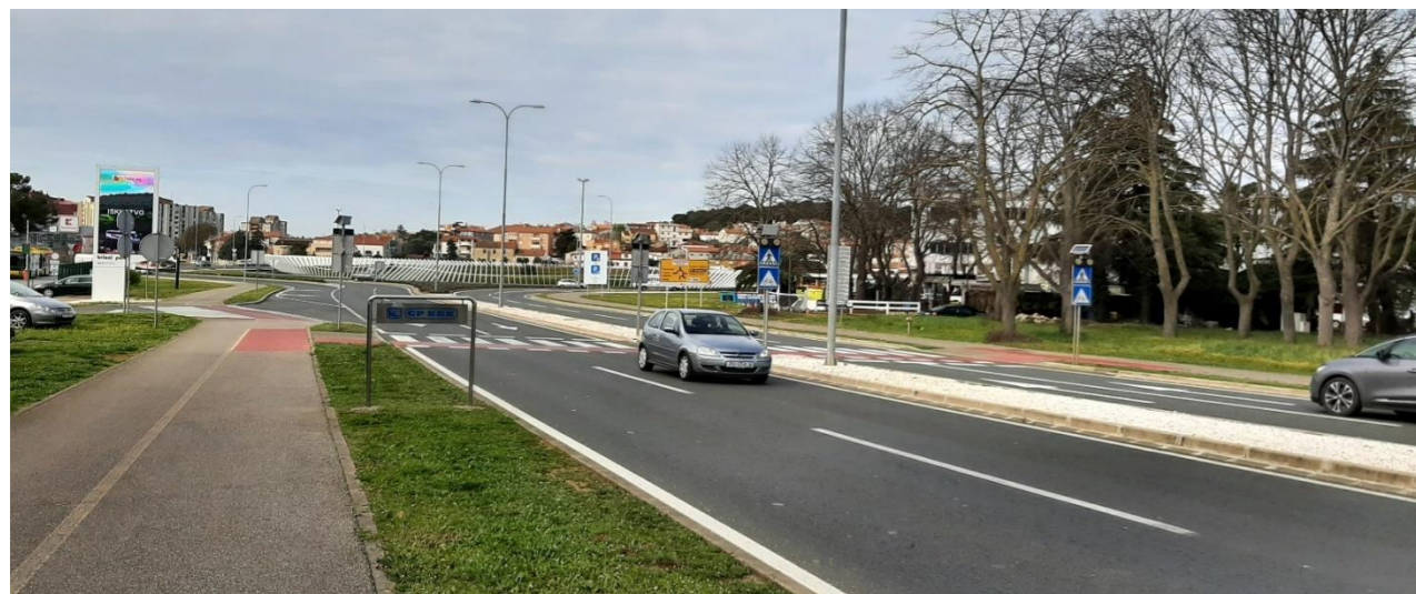
Slika 74 Rotor na pulskoj zaobilaznici (autorska fotografija)
