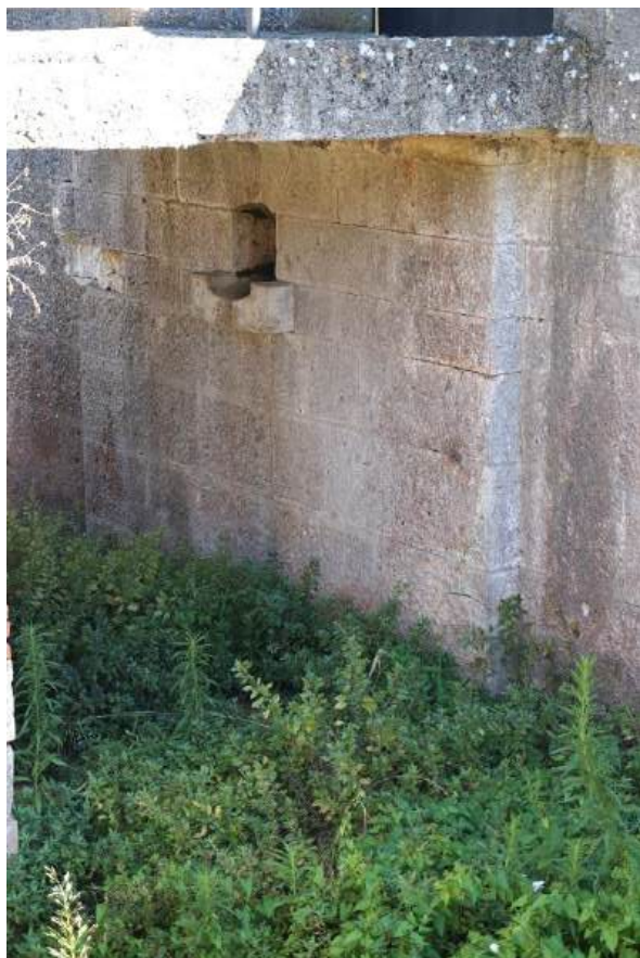
Sl. 7.262.a,b Pogled na rigol u zidu eskarpe i ambrazure u obrambenom zidu vanjskog dvorišta.
