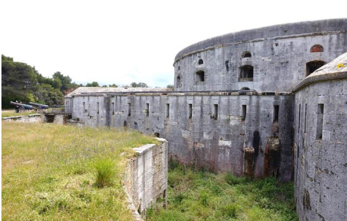
Sl. 7.195. Pogled na zapadni dio obrambenog zida sa sjeverozapada.
