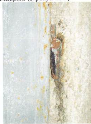
Sl. 38 Primjer željeznog nosača vrata.
