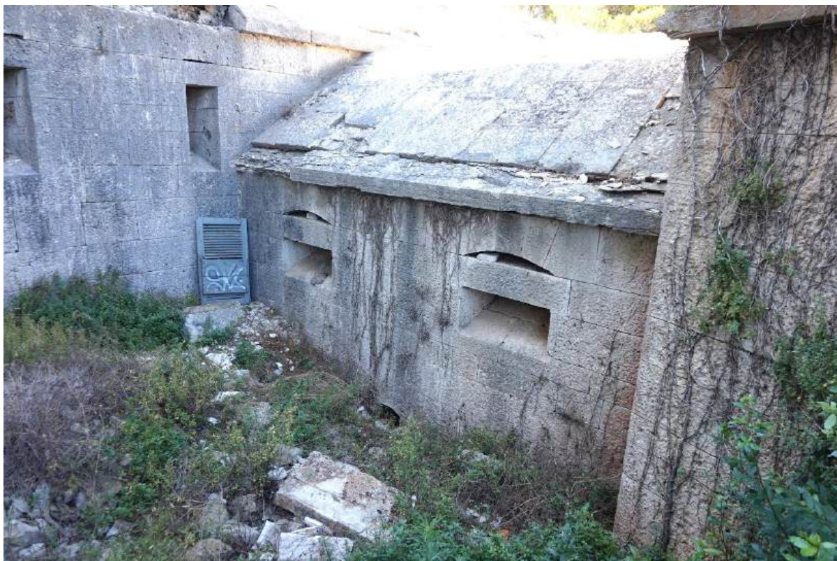
Sl. 7.219. Galerija na spoju istočnog kaponira i istočne galerije u kontraeskarpi. Južno pročelje s horizontalnim ambrazurama.
