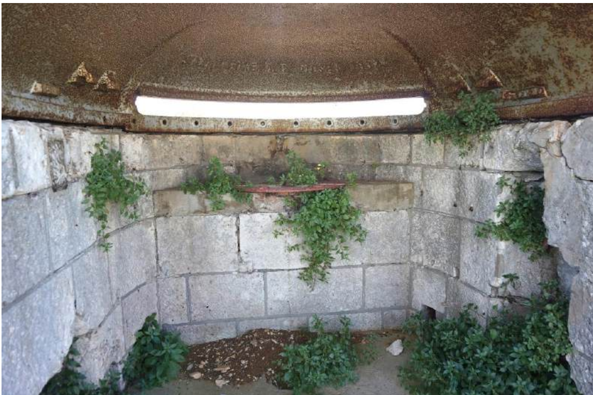
Sl. 2.30. Fort Bourguignon, osmatračnica s lijevanoželjezno kupolom na krovnoj terasi. Unutrašnjost osmatračnice s izvornim nosačem uređaja za osmatranje.
