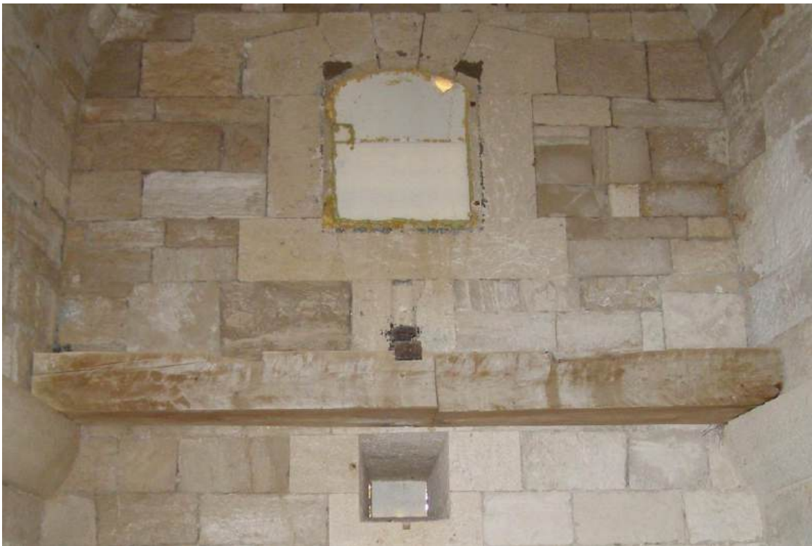
Sl. 2.12. Izvorne drvene grede i željezni element sustava lafete u zidu kazamata na katu utvrde. Izvor: Đeni Gobić-Bravar, 2011. godine.
