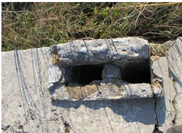
Sl. 9-10 Primjer odušnika na centralnom zidu krovišta prije i nakon zahvata 2015. godine.
