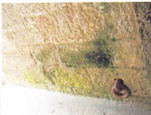
Sl. 21, 22 Kolonija algi na zidu desno i lijevo uz prolaz prema dvorištu.
