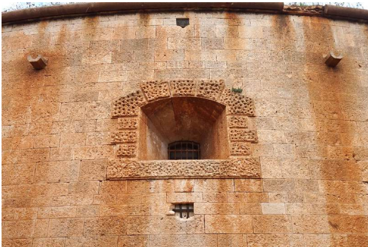
Sl. 7.211. Pogled na južno pročelje. Kat, kazamat br.
