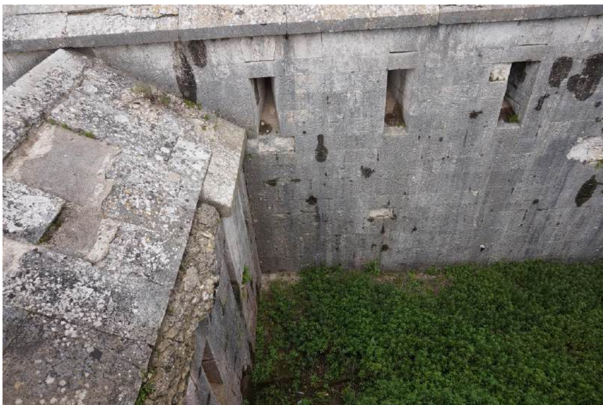
Sl. 7.222. Pogled na spoj galerije i istočnog kaponira u sjevernom opkopu.
