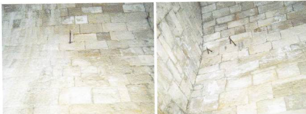
Sl. 23, 24 Volta prostorije 1, vidljivi su željezni elementi ugrađeni u blokove cementnim mortom, pretpostavlja se tijekom druge faze korištenja utvrde. Ovakvi su nosači prisutni u svim radijalnim prostorijama utvrde.
