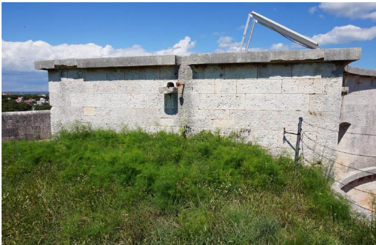
Sl. 7.170. Rigol za odvodnju oborinske vode s krova dogradnje drugog kata, zapadno pročelje.
