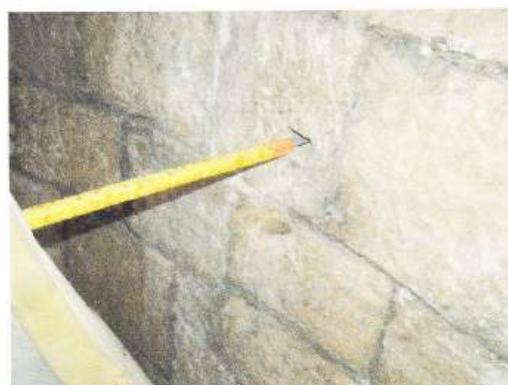
Sl. 226 Željezna ograda učvršćena u kameni blok.
