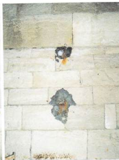
Sl. 147 Nosači u kamenom bloku.
