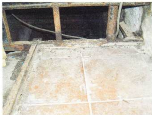
Sl. 215 Otvor prema podzemnom kanalu.
