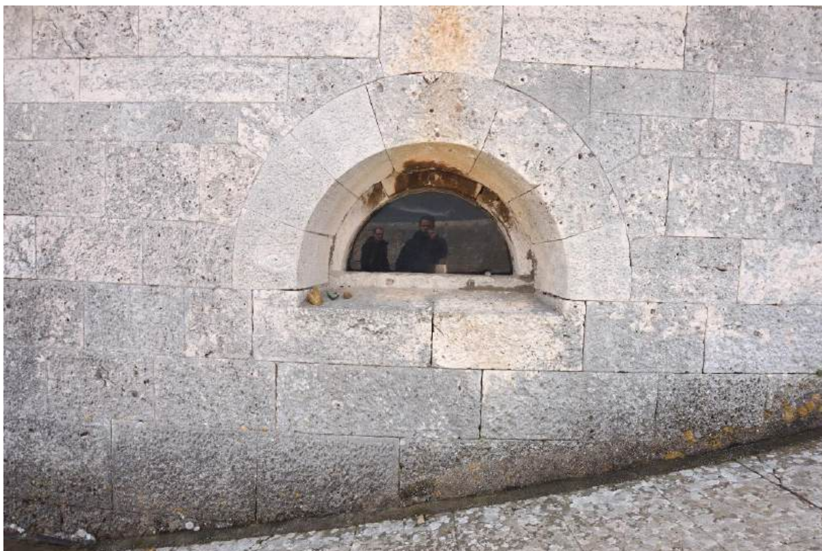
Sl. 7.149. Sjeverno pročelje gradnje nad drugim katom, polukružni otvor.
