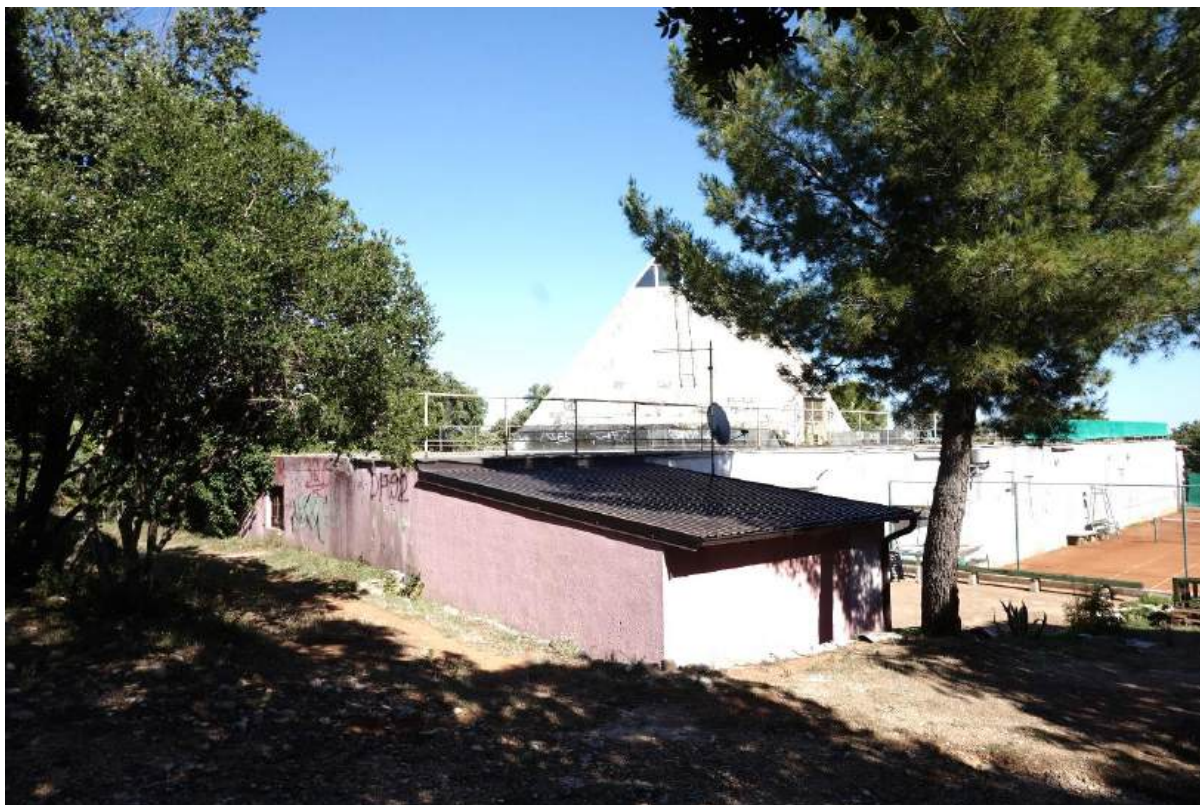
SI. 7.284. Pogled na sjeverozapadni dio građevine bivšeg kluba „Piramida“.
