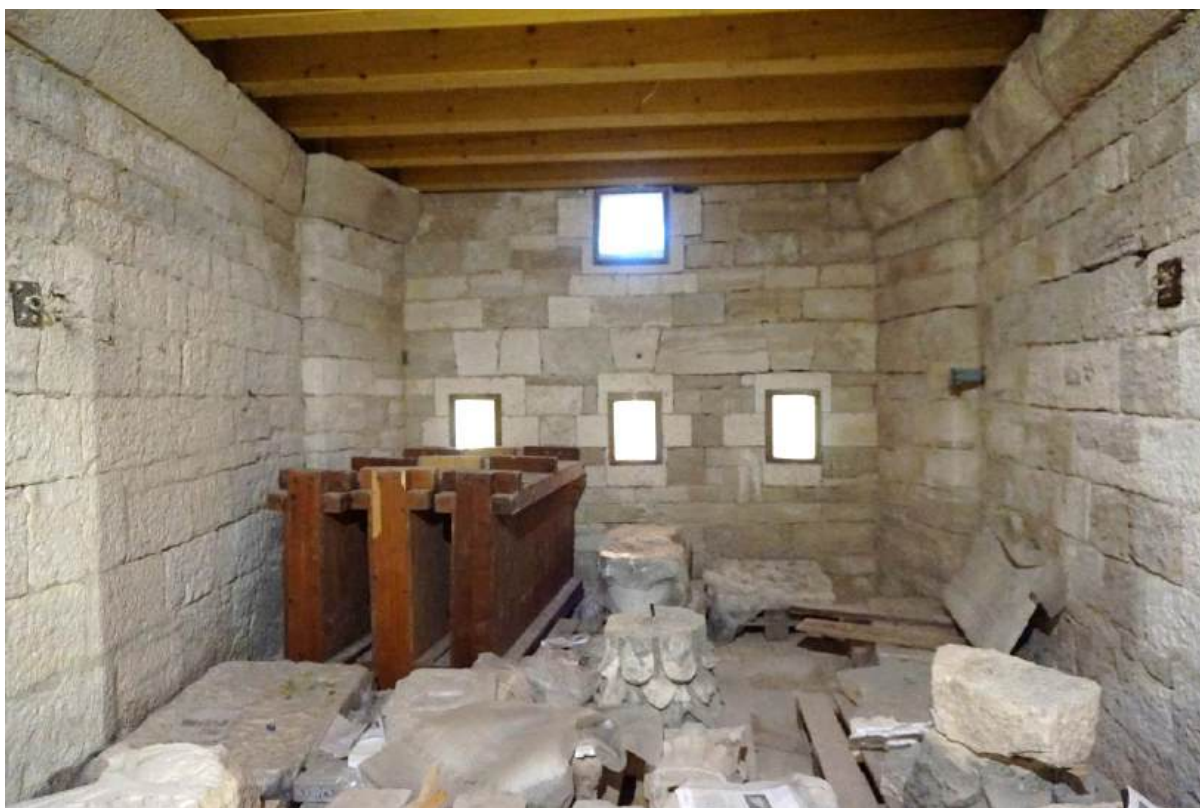
Sl. 7.44. Prizemlje, prostorija 8. Pogled na vanjski zid.
