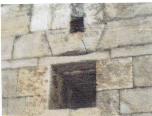
Sl. 63 Ispucani kameni blok iznad prozora.
