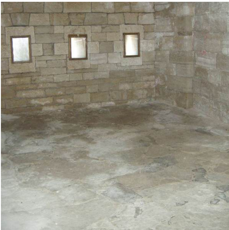
Sl. 56 Primjer kamenog poda u jednoj prizemnoj koncentričnoj prostoriji prije izgradnje međukatne konstrukcije.
