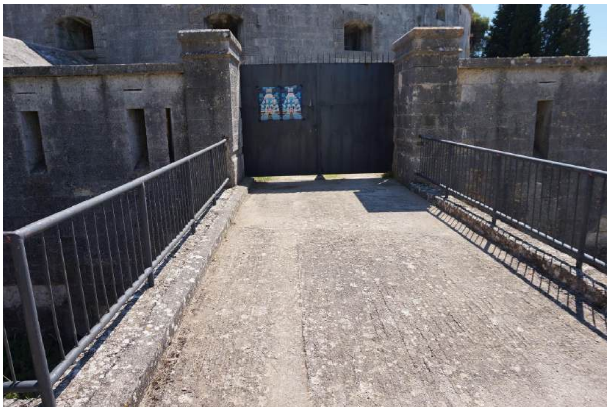
Sl. 7.258. Pogled na most i ulazni portal.
