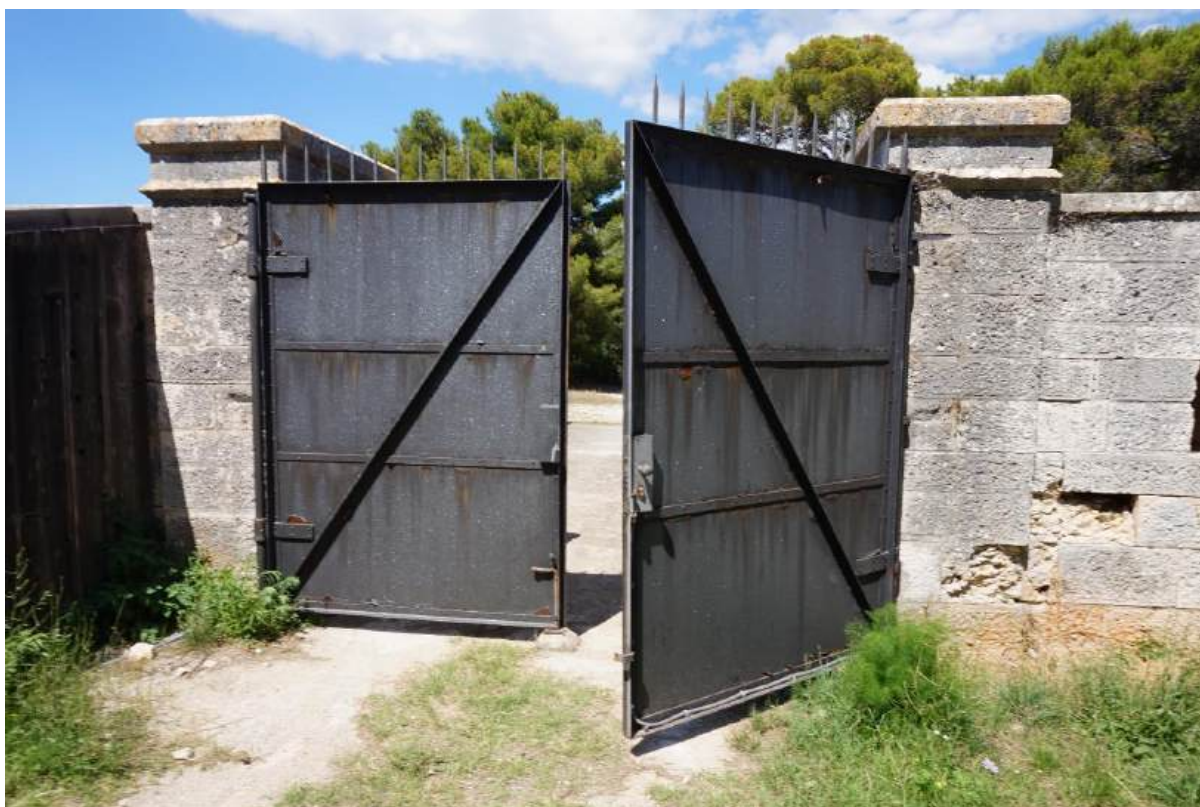
Sl. 7.255. Pogled na ulazni portal u vanjsko dvorište s dvokrilnim metalnim vratima.
