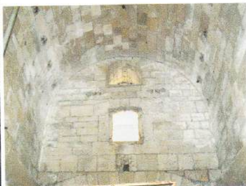
Sl. 48, 49 Svod prostorije sa vidljivim smjerom curenja vode i željeznim nosačima vjerojatno iz druge faze korištenja prostorije.
