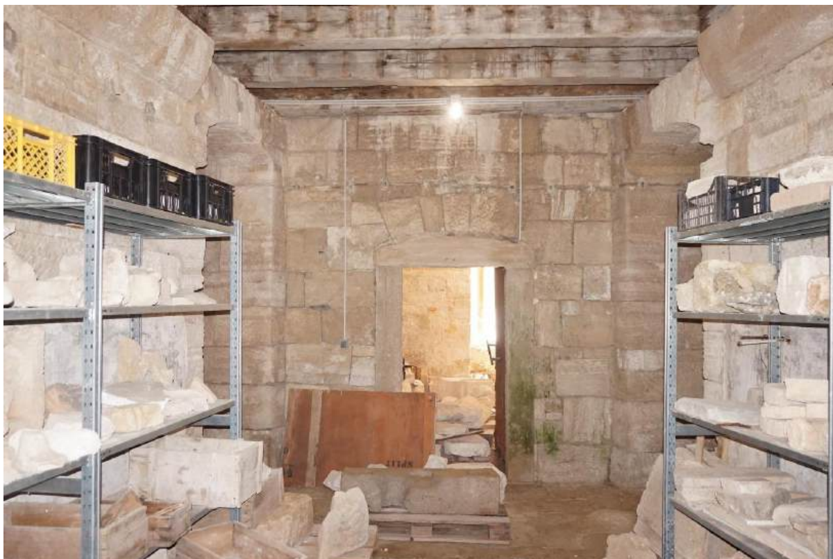
Sl. 7.20. Prizemlje, prostorija 18. Pogled na unutarnji zid i ulaz u prostoriju 23.
