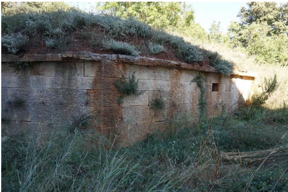
Sl. 7.236. Pogled na istočni dio zida kontraeskarpu u južnom opkopu.
