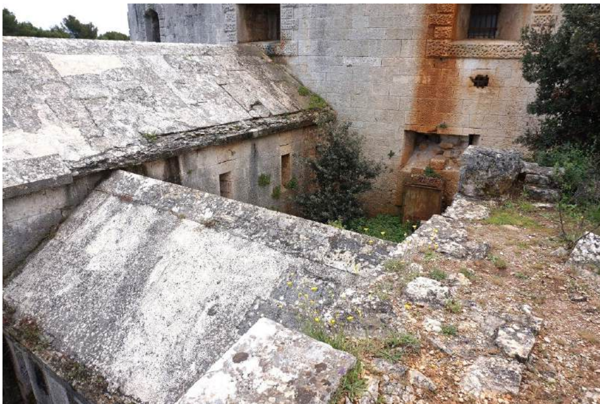
Sl. 7.200. Pogled na spoj zapadnog kaponira sa utvrdom na zapadnom pročelju.
