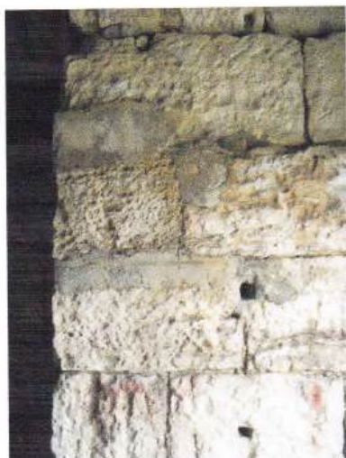
Sl. 3-4 Primjer cementnih zakrpa uz ulazni prolaz.
