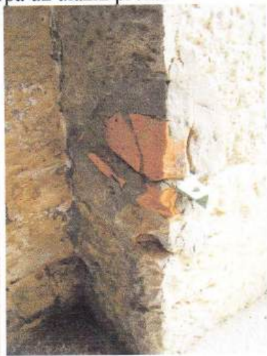
Sl. 3-4 Primjer cementnih zakrpa uz ulazni prolaz.
