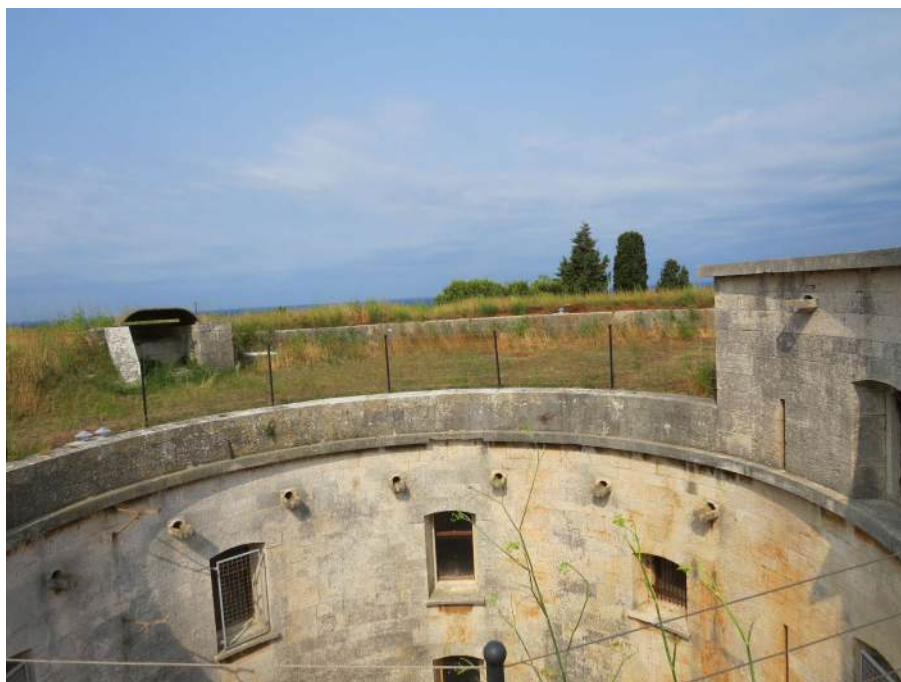
Sl. 71 Pogled na krovište.
