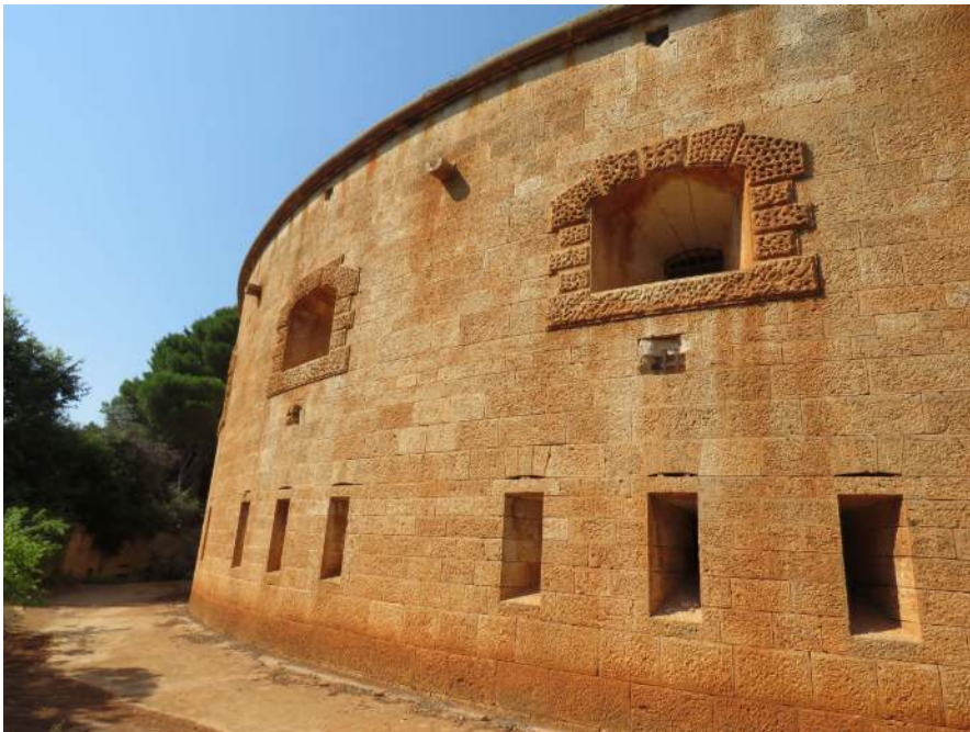
Sl. 42 Depozit crvenih pigmenata iz tenisita i zemlje crvenice na zapadnim površinama utvrde.
