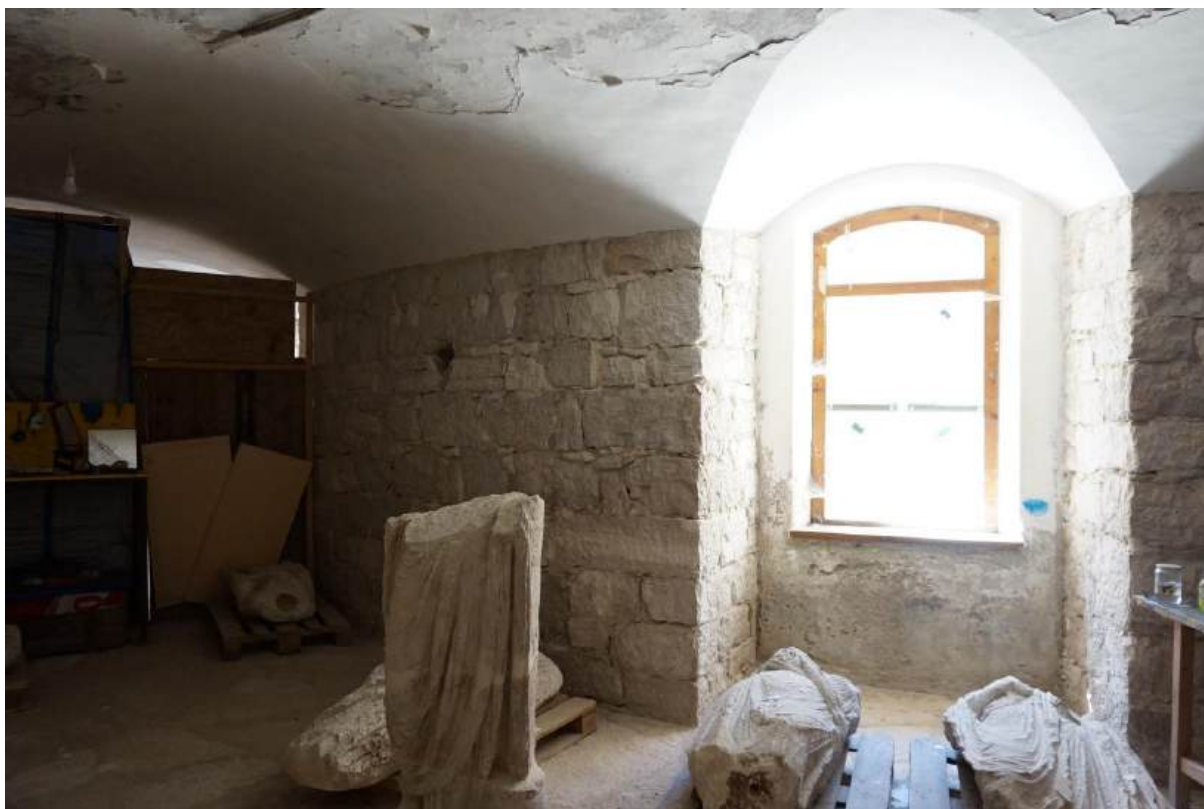
Sl. 7.92. Prizemlje, prostorija 24. Pogled prema prozoru na unutarnje dvorište.
