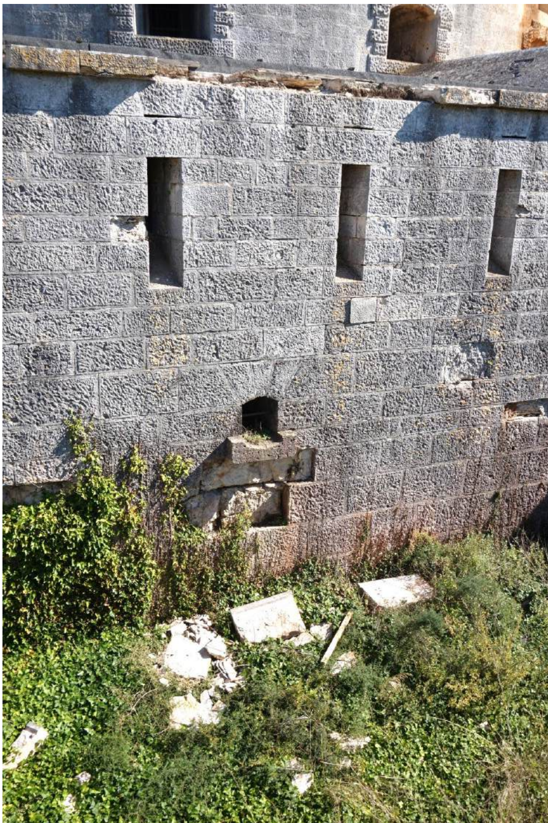
Sl. 7.197. Pogled sa sjeverozapada na eskarpu u zapadnom dijelu sjevernog opkopa.
