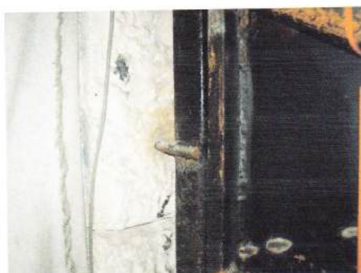
Sl. 122, 123 Detalji montaže vrata u kamene blokove.
