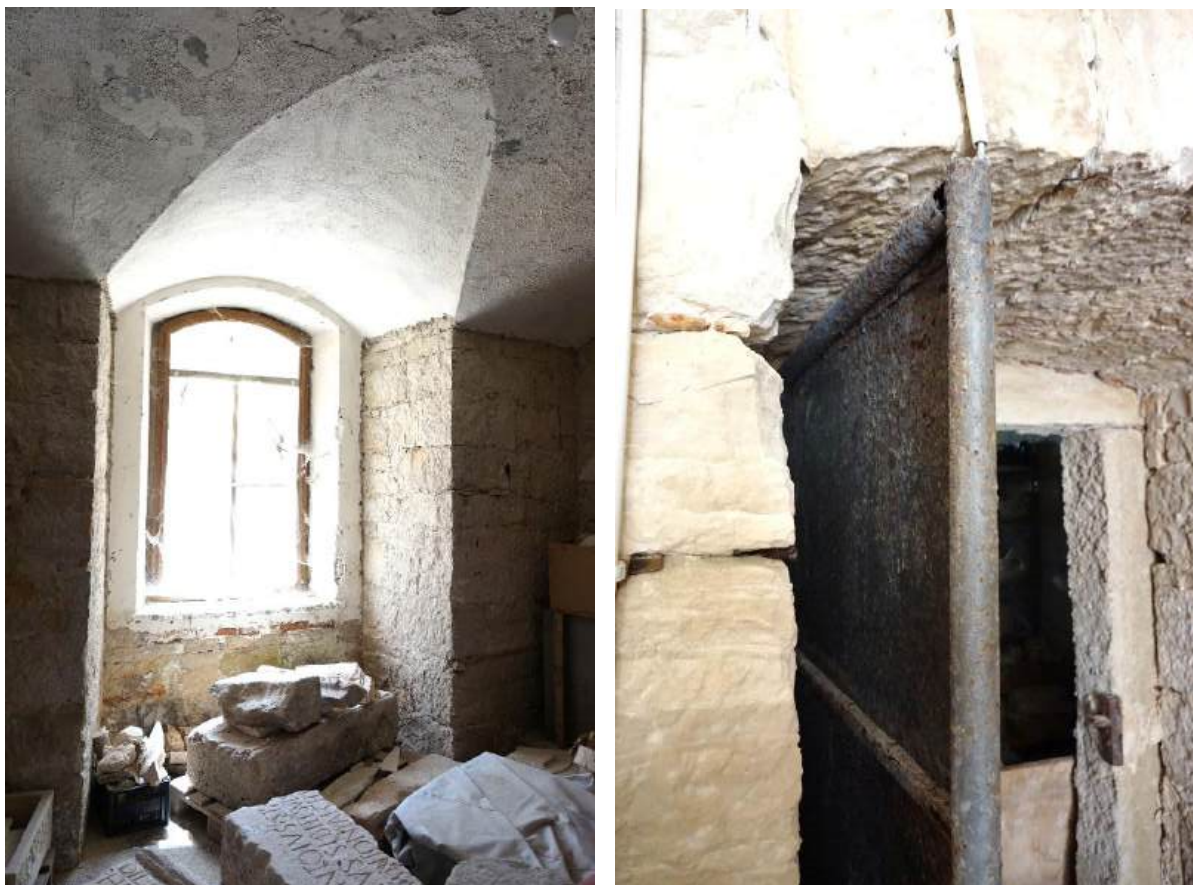
Sl. 7.89. a, b Prizemlje, prostorija 23. Pogled prema prozoru na unutarnje dvorište; Detalj vrata.
