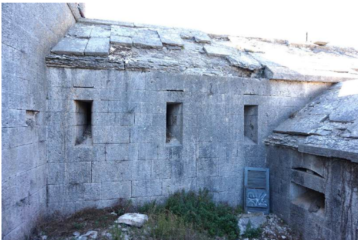
Sl. 7.220. Pogled na istočno pročelje istočnog kaponira. Spoj s centralnim volumenom građevine.
