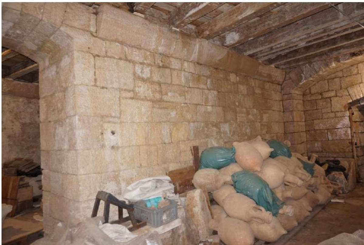
Sl. 7.16. Prizemlje, prostorija 19. Pogled na zid između prostorija 19 i 20.
