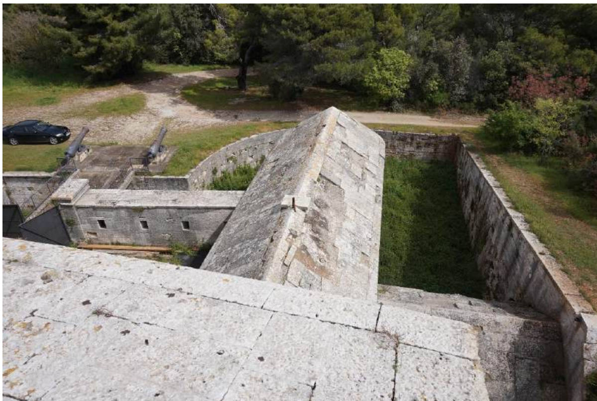
Sl. 7.223. Pogled na krov zapadnog kaponira.
