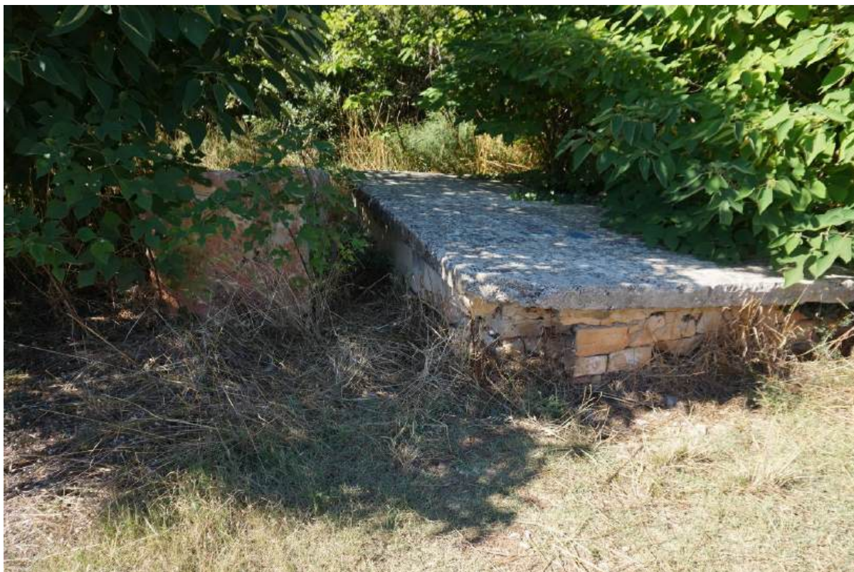
Sl. 7.294. Pogled na infrastrukturnu građevinu sjeverozapadno od utvrde.
