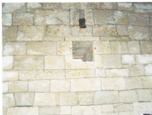
Sl. 68 Puknuti kameni blok iznad prozora.
