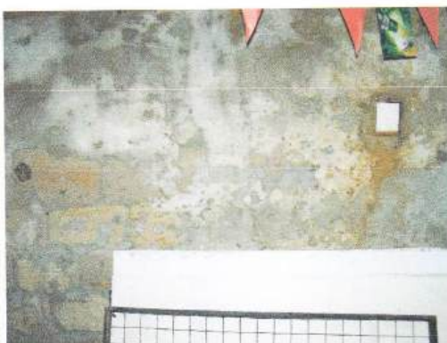
Sl. 27, 28 Cementnim mortom ožbukani prizemni dio prostorije 2.
