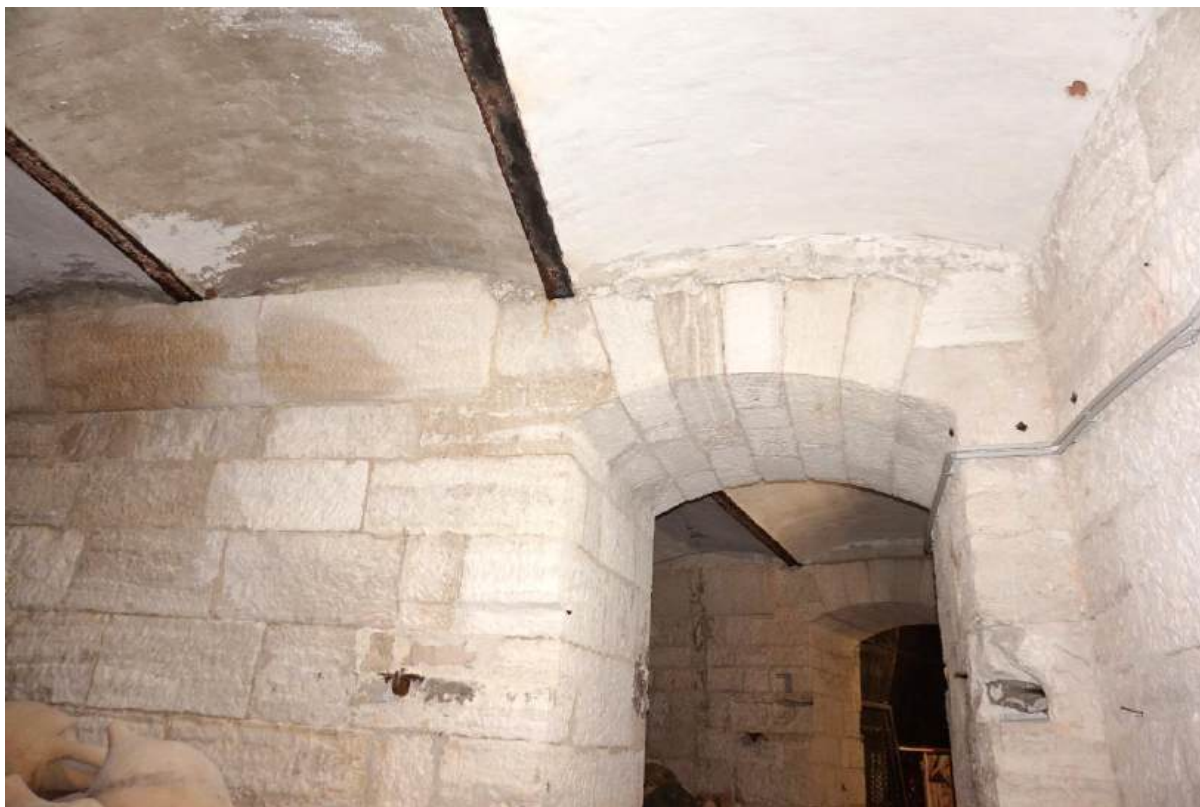
Sl. 7.53. Prizemlje, prostorija 6. Pogled na nadvoj otvora u zidu između prostorija 6 i 5.
