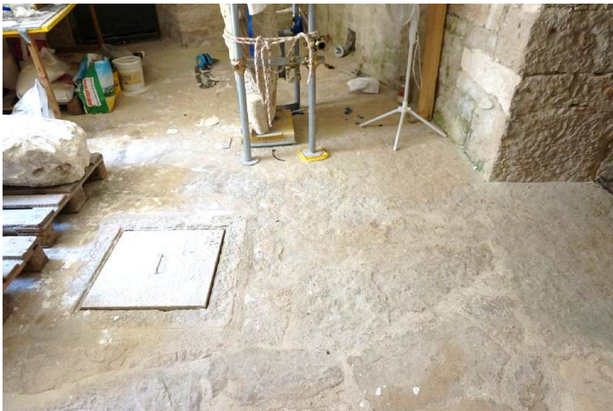
SI. 7.94. Prizemlje, prostorija 24. Pod od lomljenih kamenih ploča.
