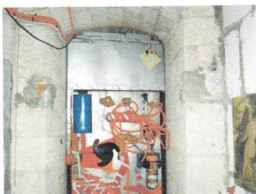
Sl. 136 Vrata i instalacije.
