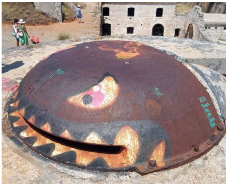
Sl. 2.31. Osmatračnica s lijevanoželjezno kupolom na obalnoj poligonalnoj blindiranoj utvrdi Monforno (Forno) u Općini Bale, gradnja utvrde započela je 1904. godine.
