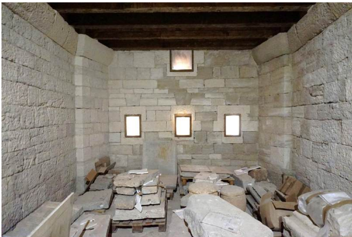
Sl. 7.36. Prizemlje, prostorija 10. Pogled na vanjski zid.
