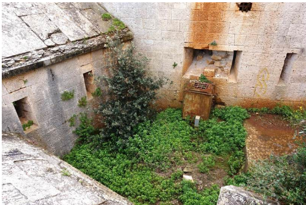
Sl. 7.201. Pogled na spoj zapadnog kaponira sa utvrdom na zapadnom pročelju u obrambenom rovu.
