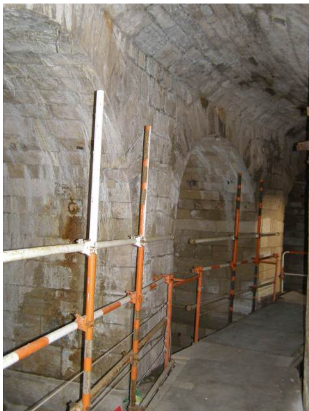
Sl. 5 Privremena pristupna rampa koja je spajala stubište i centralnu cirkularnu prostoriju prvog kata, 2010. godine.
