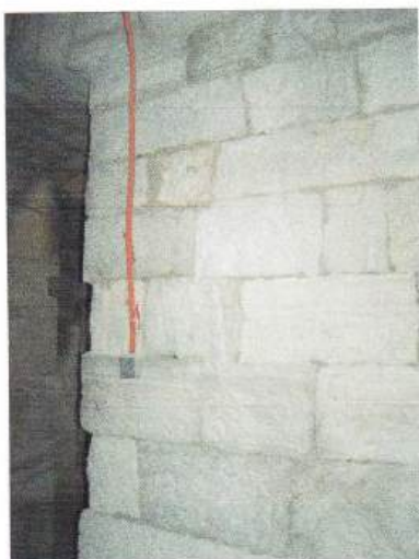
Sl. 81 Instalacije struje.
