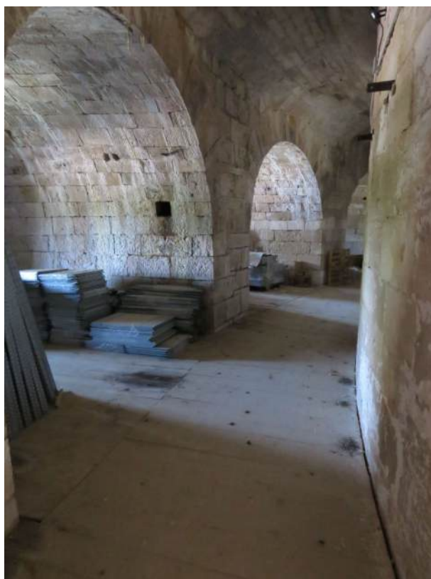
Sl. 6 Nova drvena međukatna konstrukcija izvedena 2013. godine.
