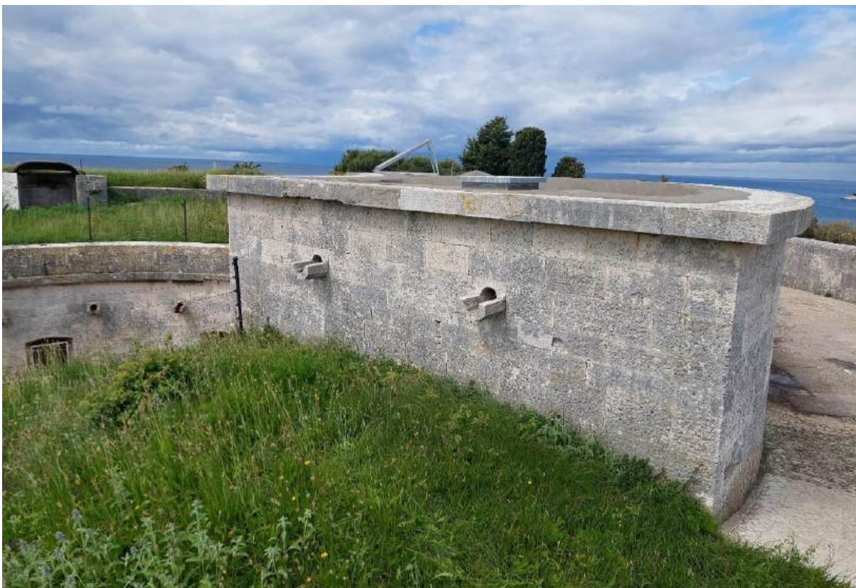
Sl. 7.160. Gradnja drugog kata za pristup krovnoj terasi, istočno pročelje.
