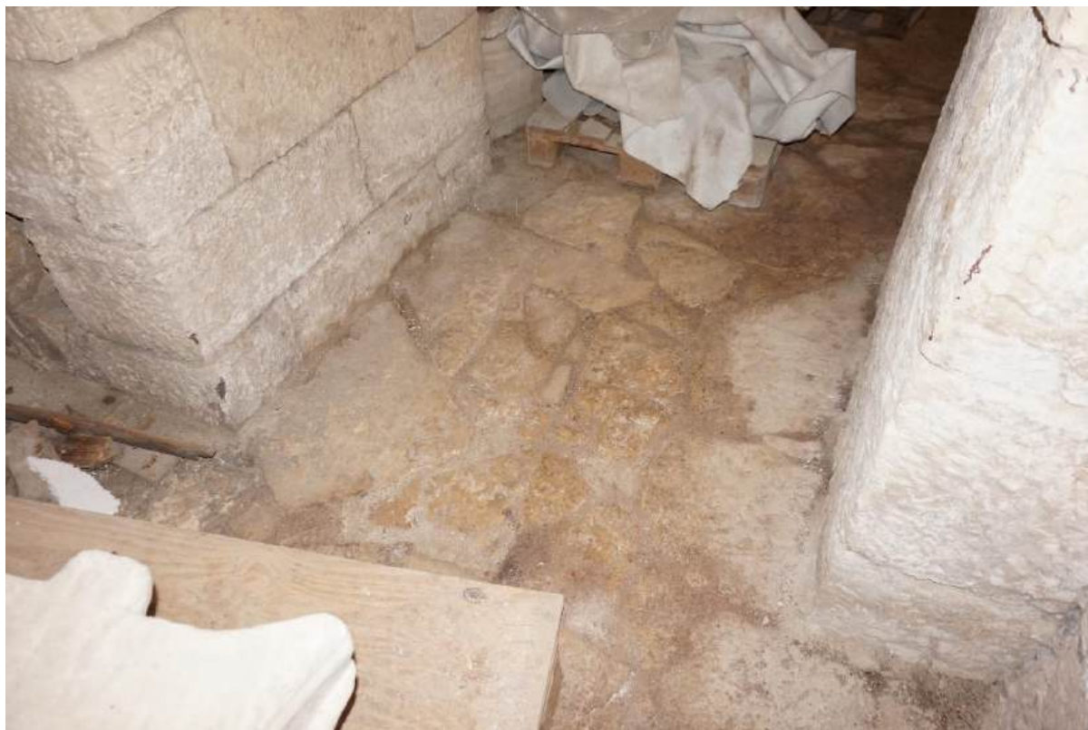
Sl. 7.14. Prizemlje, prostorija 20. Pogled na otvor između prostorija 20 i 19.
