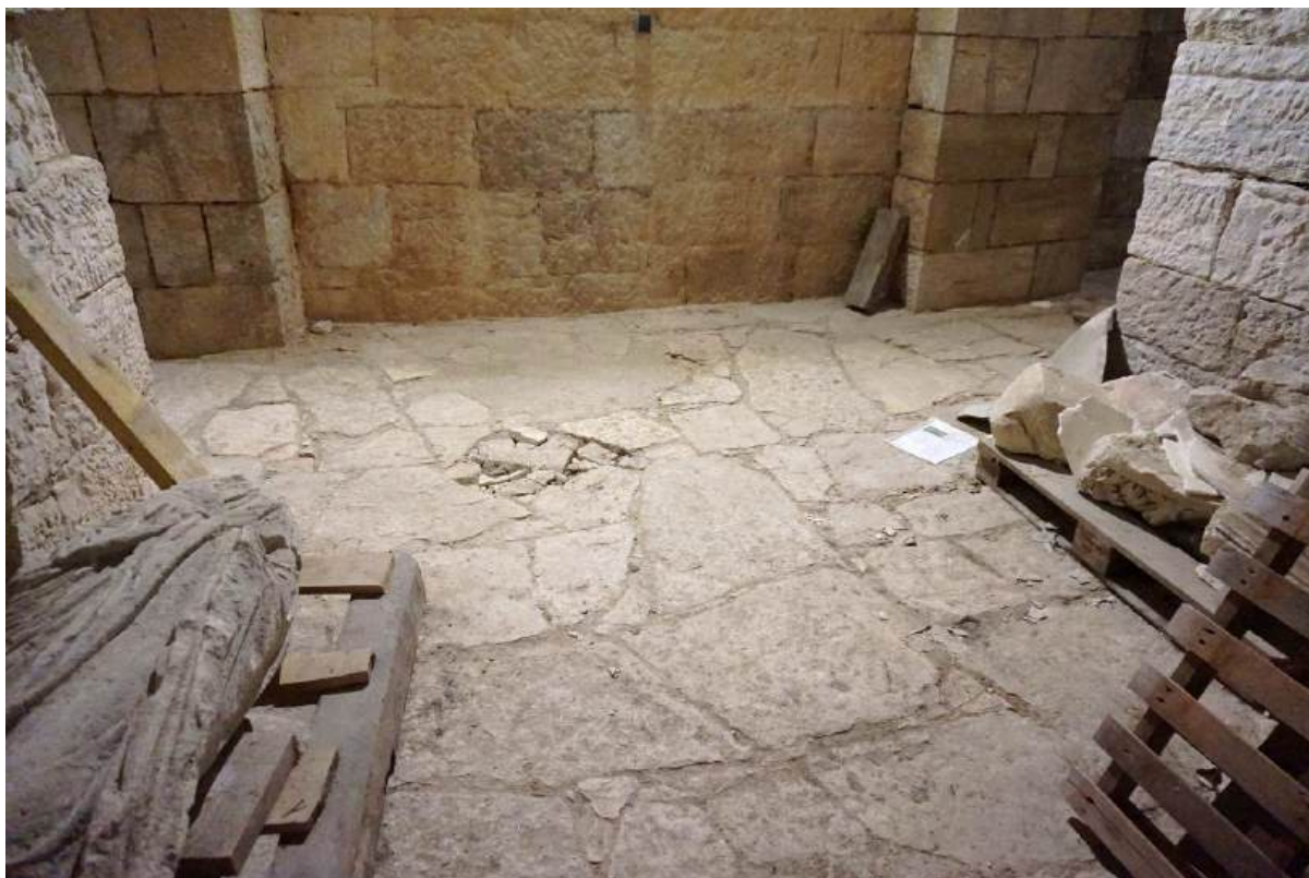
Sl. 7.30. Prizemlje, prostorija 13. Pogled na pod prostorije.
