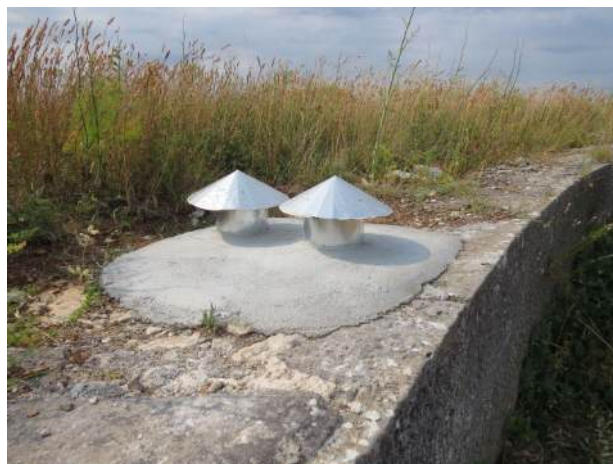
Sl. 9-10 Primjer odušnika na centralnom zidu krovišta prije i nakon zahvata 2015. godine.
