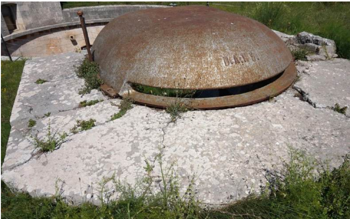
Sl. 2.29. Fort Bourguignon, osmatračnica s lijevanoželjeznom kupolom na krovnoj terasi
