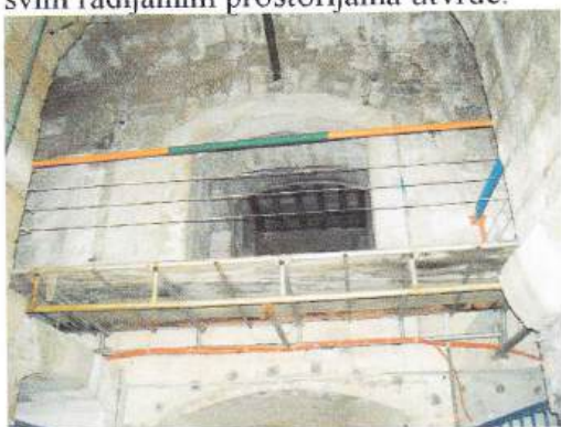
Sl. 23, 24 Volta prostorije 1, vidljivi su željezni elementi ugrađeni u blokove cementnim mortom, pretpostavlja se tijekom druge faze korištenja utvrde. Ovakvi su nosači prisutni u svim radijalnim prostorijama utvrde.
