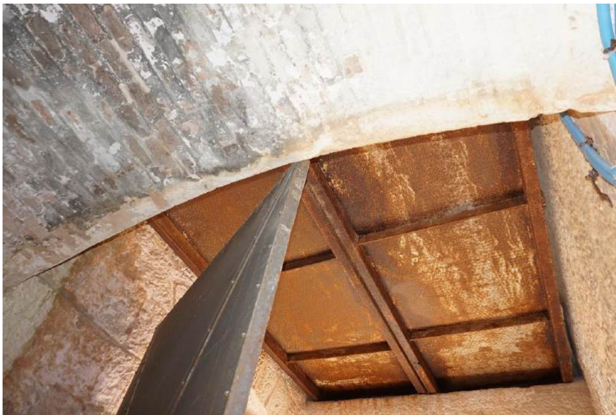
Sl. 7.80. Prizemlje, prostorija 21. Pogled na strop.
