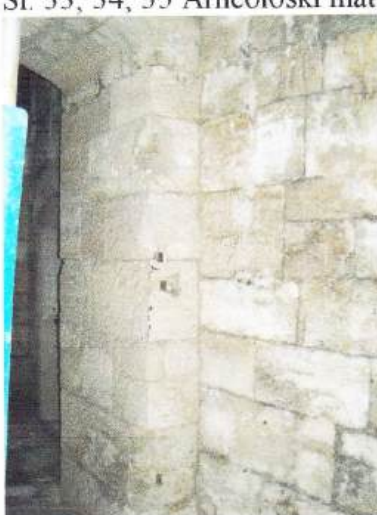
Sl. 36, 37 Odlomljeni ugao zida.
