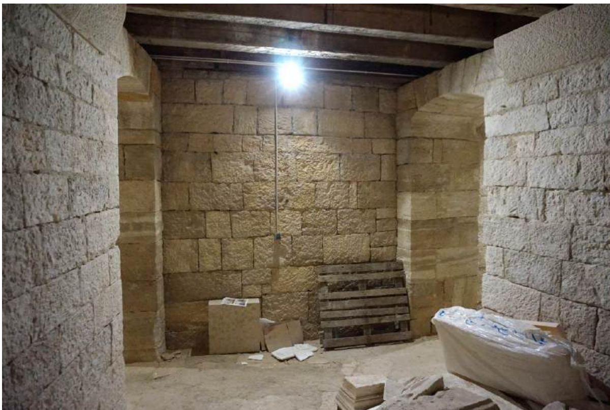
Sl. 7.35. Prizemlje, prostorija 11. Pogled na unutarnji zid.
