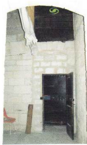
Sl. 98, 99, 100 Pregrađen prolaz prema prostoriji 14 sa ugrađenim vratima, vrata na gornjem katu.
