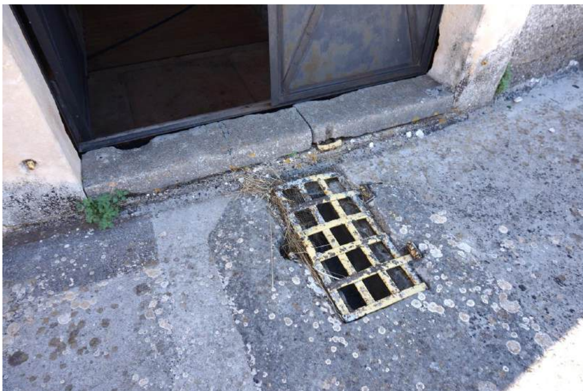
Sl. 7.151. Ulazni portal na krovnu terasu, metalna rešetka odvodnog kanala terase.
