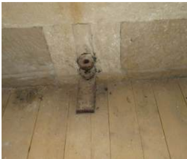
Sl. 60-61 Detalji izvorno ugrađenih željeznih elemenata u kamen unutarnjih zidova utvrde.
