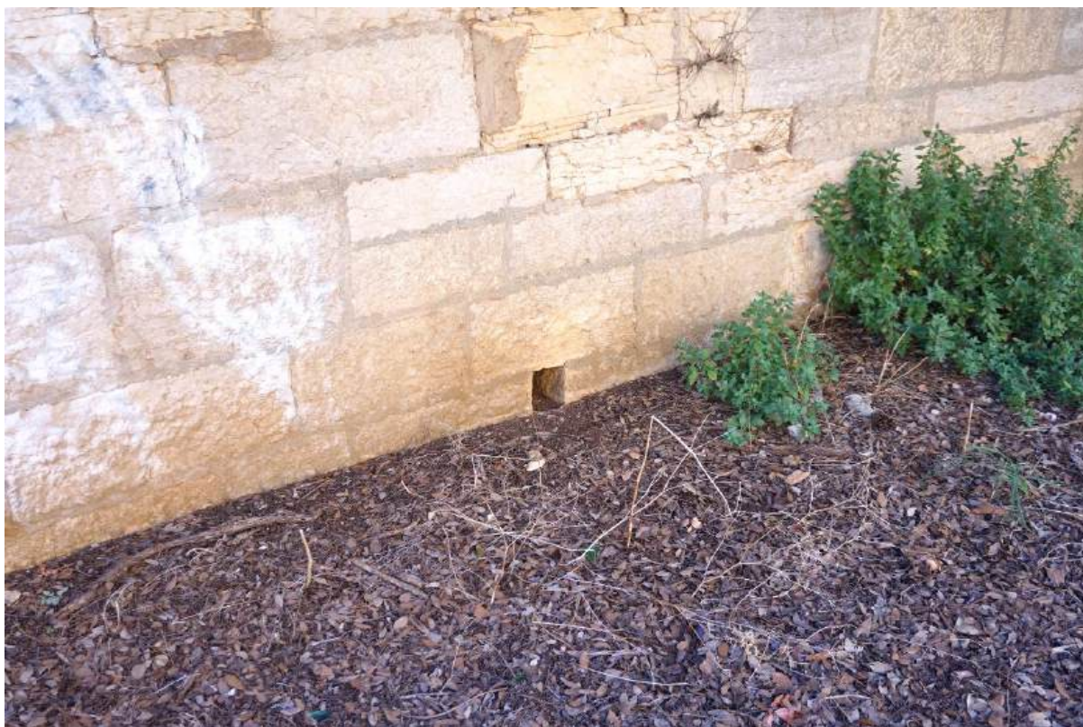
Sl. 7.231. Otvor za ocjeđivanje zida kontraeskarpe.
