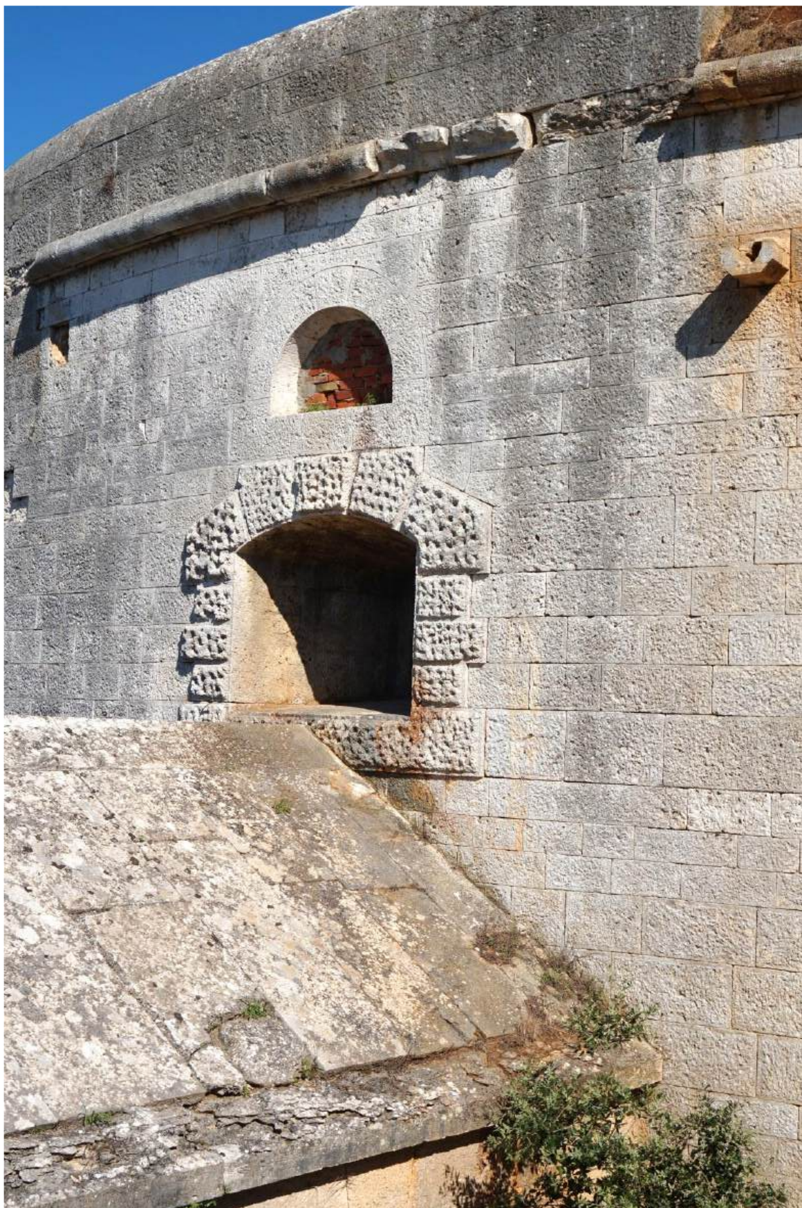
Sl. 7.207. Pogled na sjeverozapadno pročelje. Spoj zapadnog kaponira s utvrdom.
