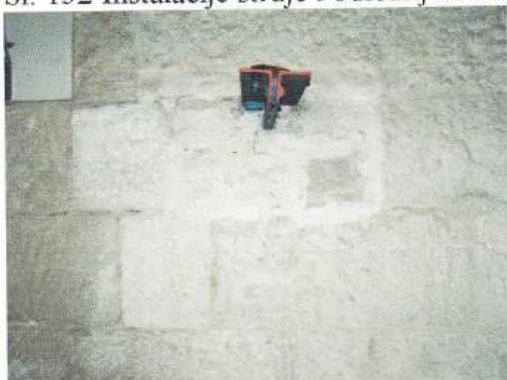
Sl. 134 Nosač montiran u kameni blok.
