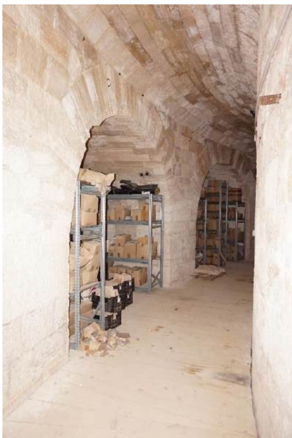
Sl. 7.135. Kat, prostorija 6. Pogled u smjeru vanjskog zida.
