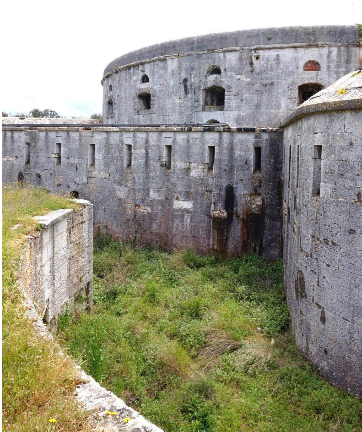
Sl. 7.194. Pogled na zapadni dio obrambenog zida vanjskog dvorišta i obrambenim rovom s kontraeskarpom.
