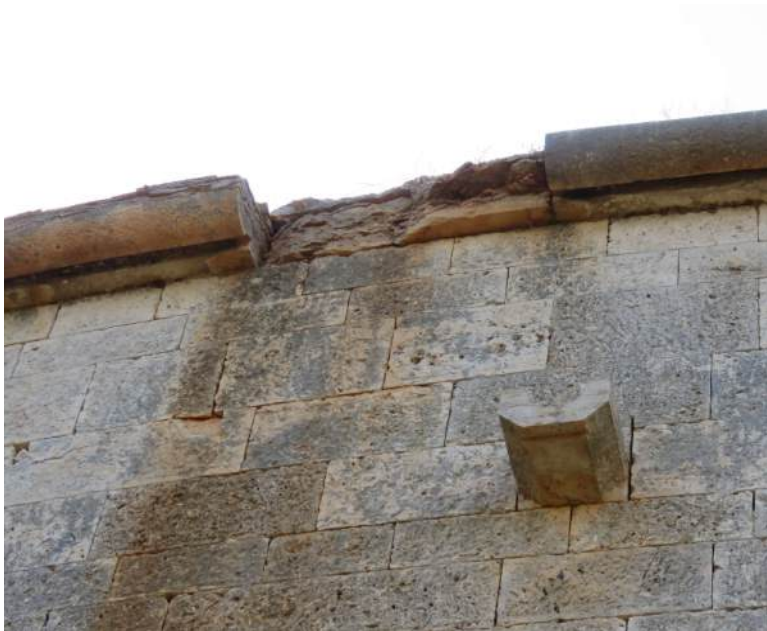
Sl. 76 Nedostajući element kamenog vijenca kruništa utvrde.
