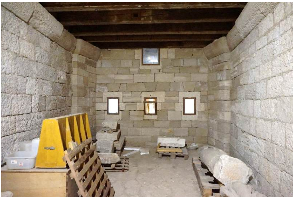
SI. 7.28. Prizemlje, prostorija 13. Pogled na vanjski zid.
