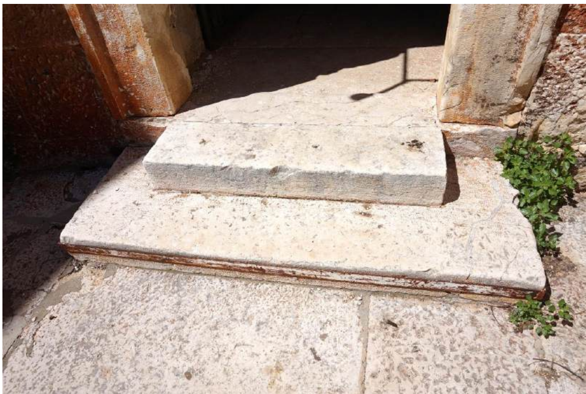
Sl. 7.182. Unutarnje dvorište, pogled prema sjeveru. Glavni ulazni portal u dvorište.
