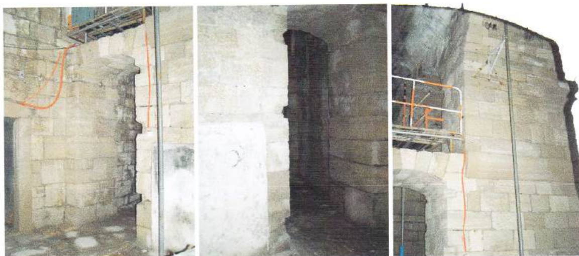
Sl. 41, 42, 43 Strujne instalacije, odlomljeni uglovi i montirani željezni nosač.
