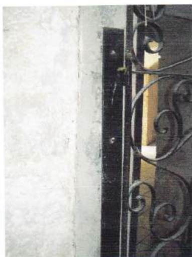
Sl. 80, 81 Vrata prema prostoriji 22 i detalj nosača montiran u kameni dovratnik premazan cementnim mortom.
