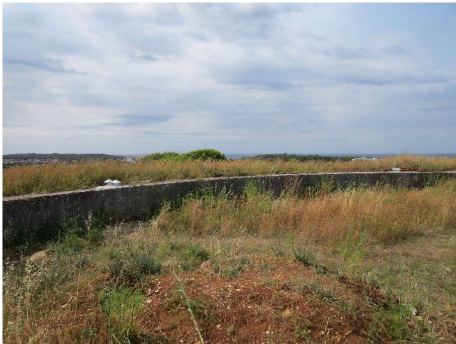
Sl. 70 Pogled na zid koji dijeli dva koncentrična prstena zemljanog nasipa krovišta.
