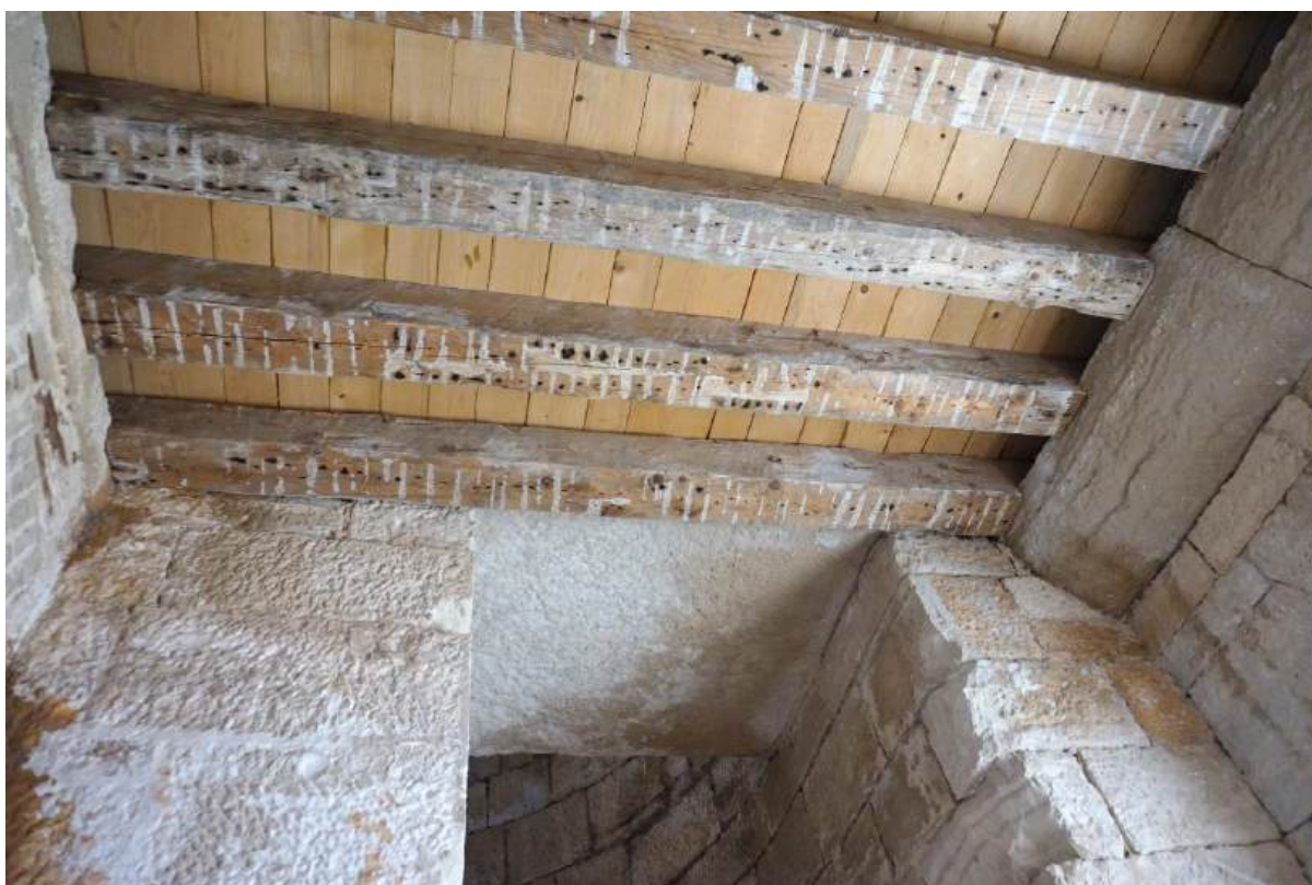
Sl. 7.115. Kat, prostorija 22. Pogled na međukatnu konstrukciju.
