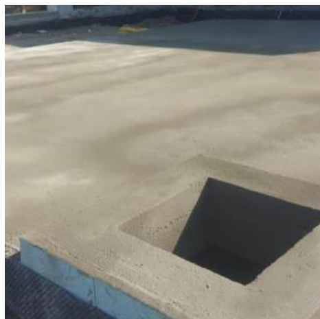
Prikaz primjene hidroizolacije OMBRAN ASP i završni izgled površine koja bi bila ispod kamenih podnih obloga
