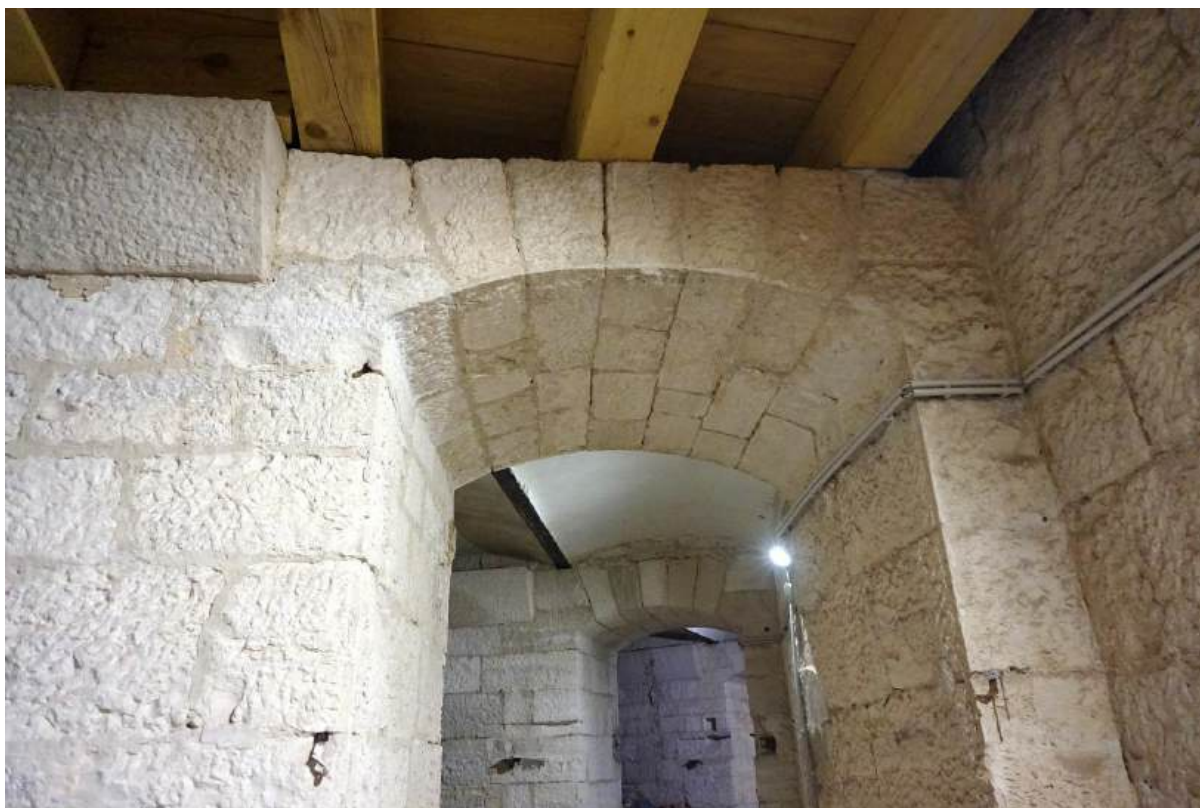
SI. 7.49. Prizemlje, prostorija Pogled na nadvoj otvora prema prostoriji 6.
