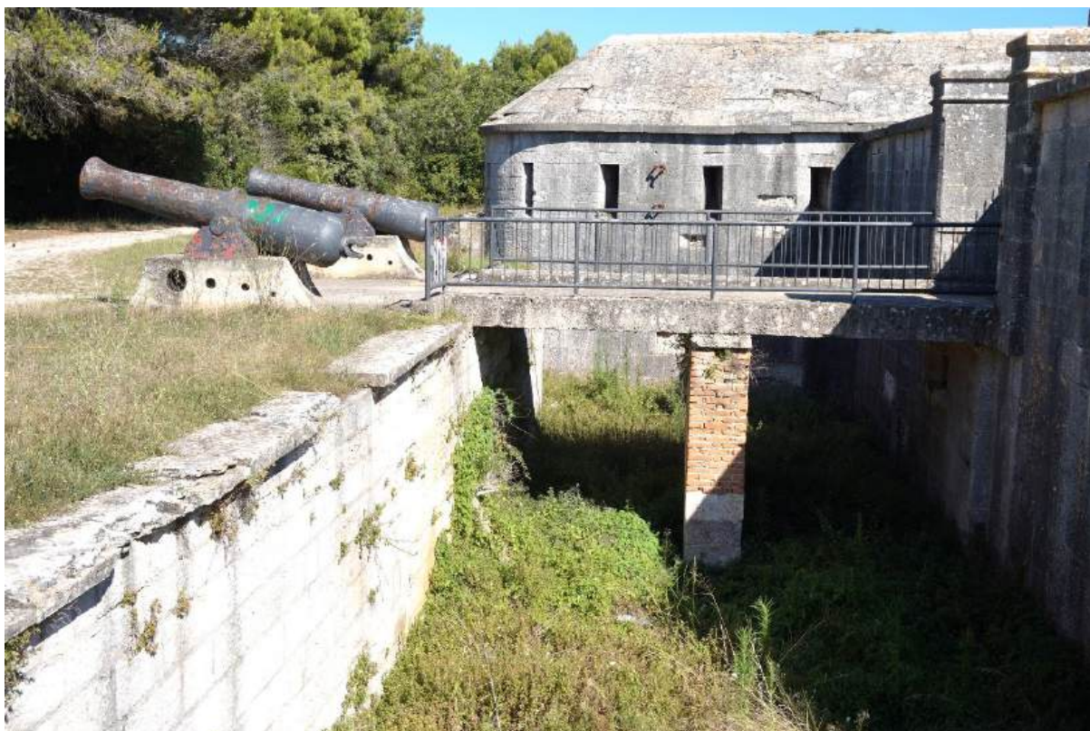
Sl. 7.261. Pogled na most sa zapada.
