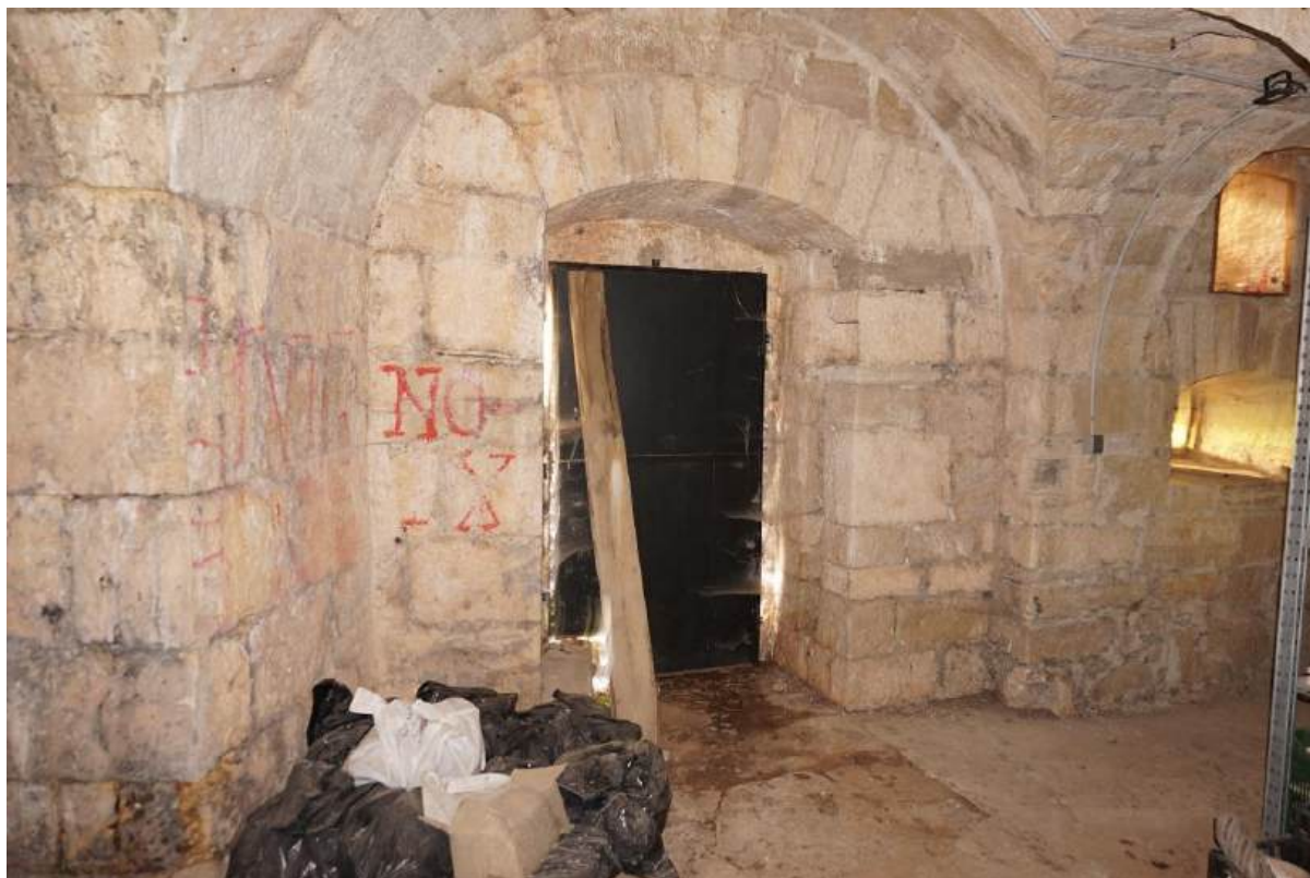
Sl. 7.75. Prizemlje, zapadni kaponir (prostorija 30). Pogled na vrata za izlaz u opkop.
