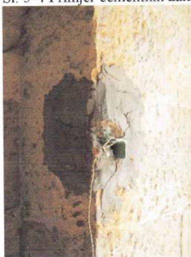
Sl. 3-4 Primjer cementnih zakrpa uz ulazni prolaz.
