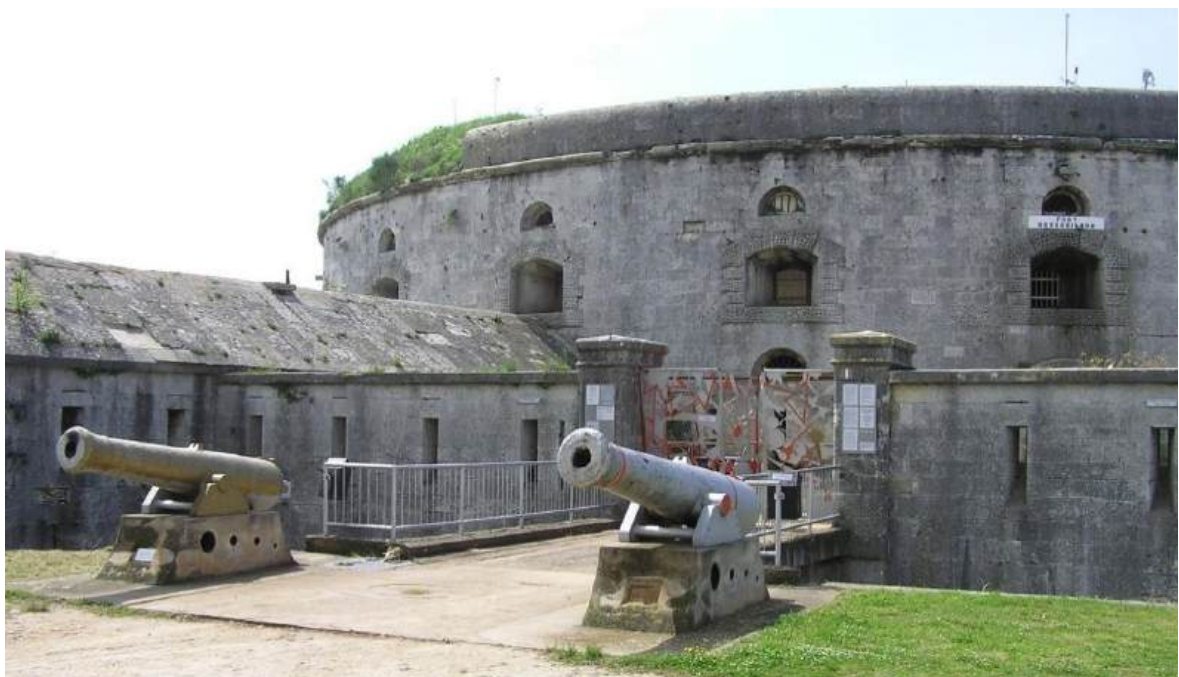
Sl. 5.49. Fort Bourguignon iz zraka. Iz vremena kada je utvrdu koristila tvrtka „Superkraft“ d.o.o.
