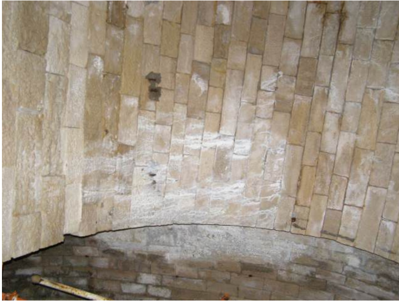
Sl. 78 Inkrustacije kalcifikacija uzrokovane curenjem vode.
