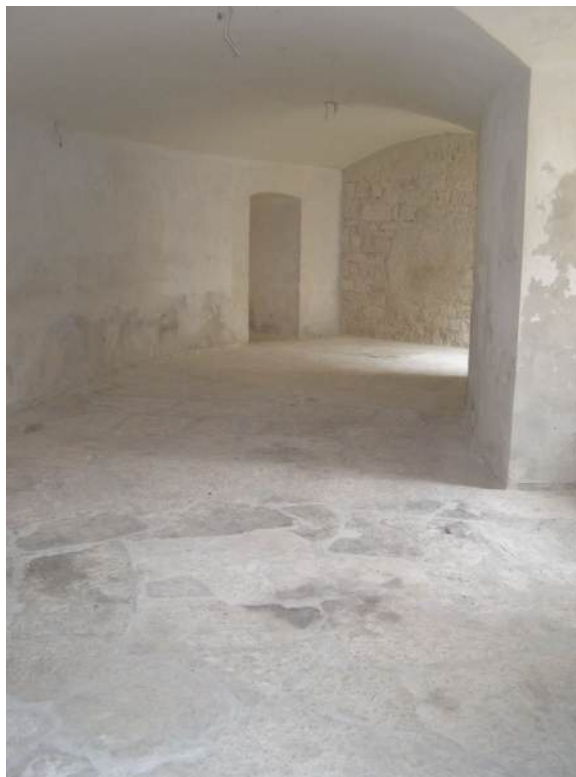
Sl. 3-4 Podovi prizemnog centralnog cirkularnog hodnika nakon vraćanja u izvorno stanje.
