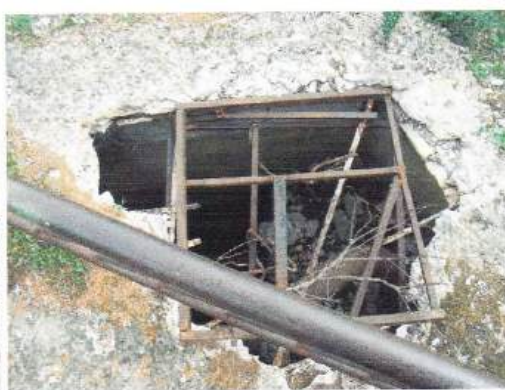
Sl. 218, 219 Detalji proboja strukture iznutra i izvana.
