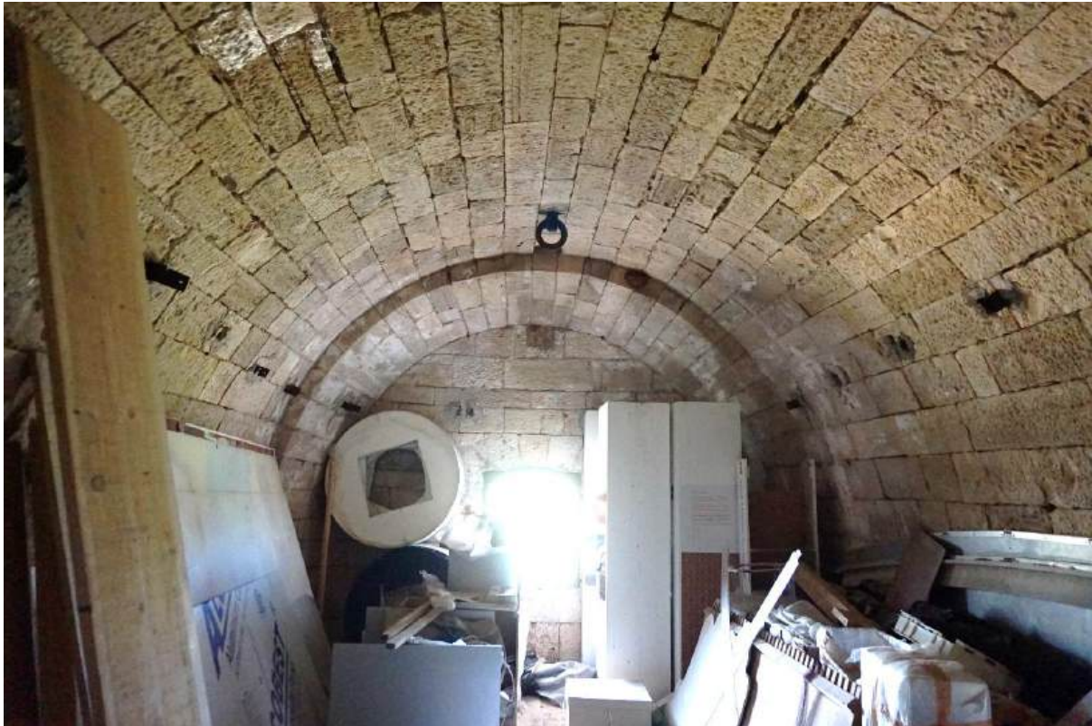
Sl. 7.131. Kat, prostorija 4. Pogled u smjeru vanjskog zida.
