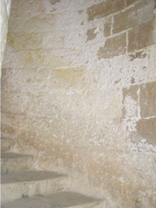
Sl. 79 Vapneni premaz koji u vidu filma prekriva površine kamena.
