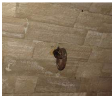
Sl. 60-61 Detalji izvorno ugrađenih željeznih elemenata u kamen unutarnjih zidova utvrde.
