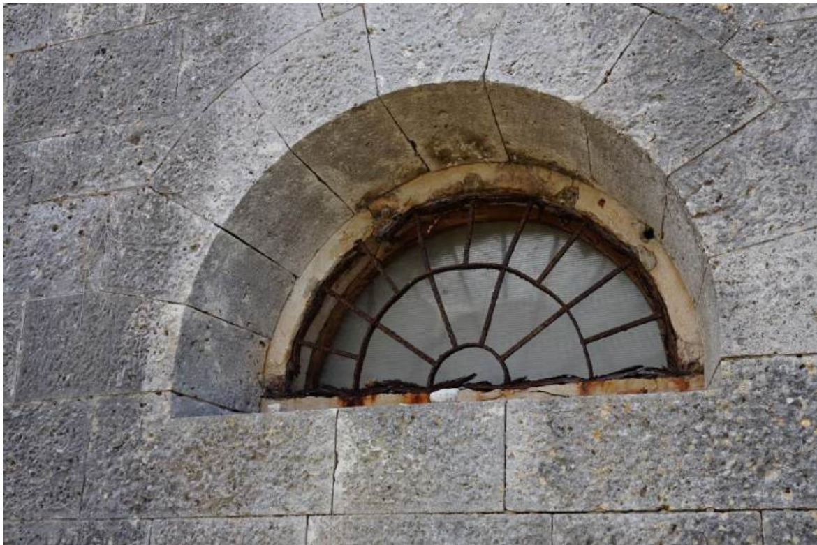
Sl. 2.20. Izvorna zaštitna rešetka na polukružnom otvoru sjevernog pročelja, prostorija 20, prizemlje.
