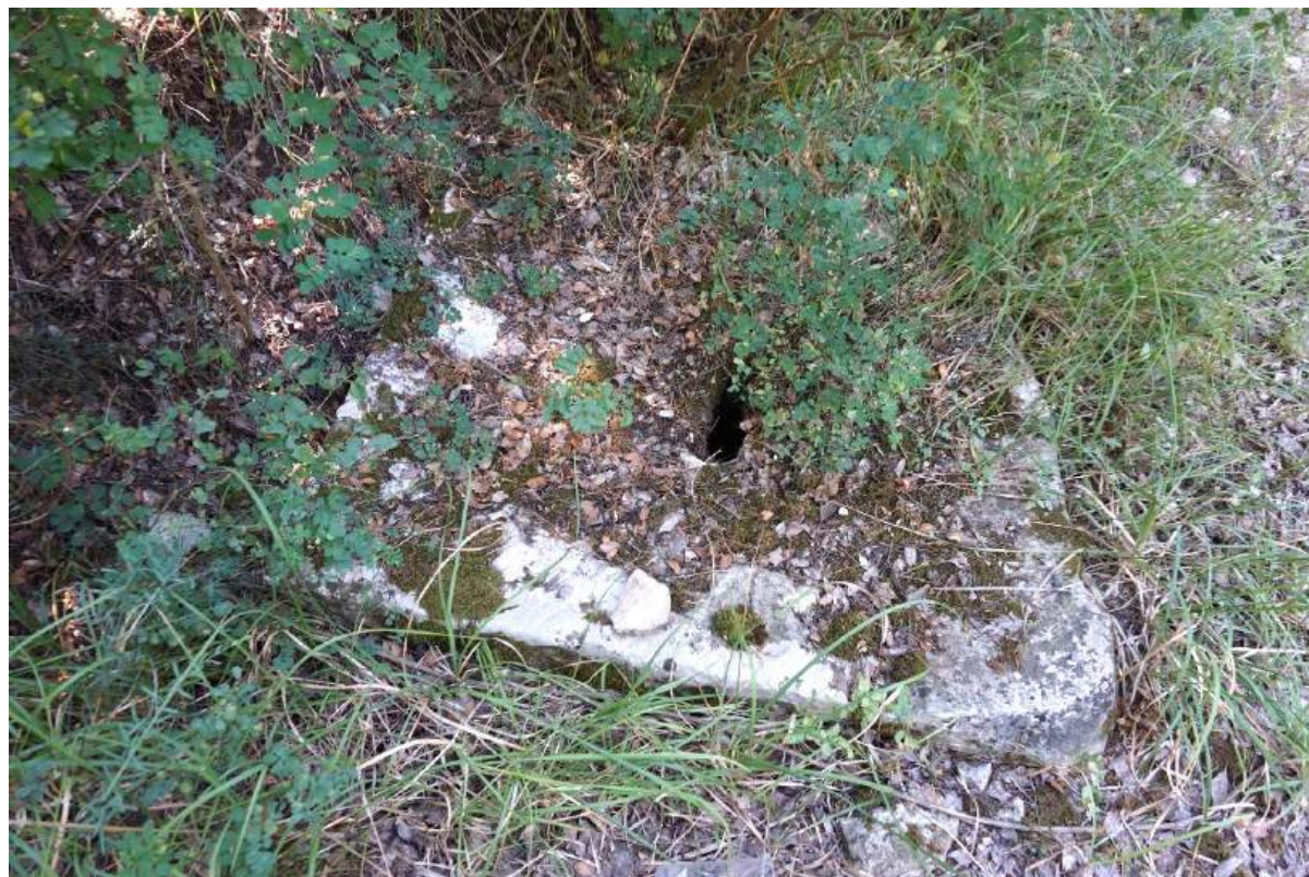
Sl. 7.270. Pogled na kamenu rešetku odvodnog kanala.
