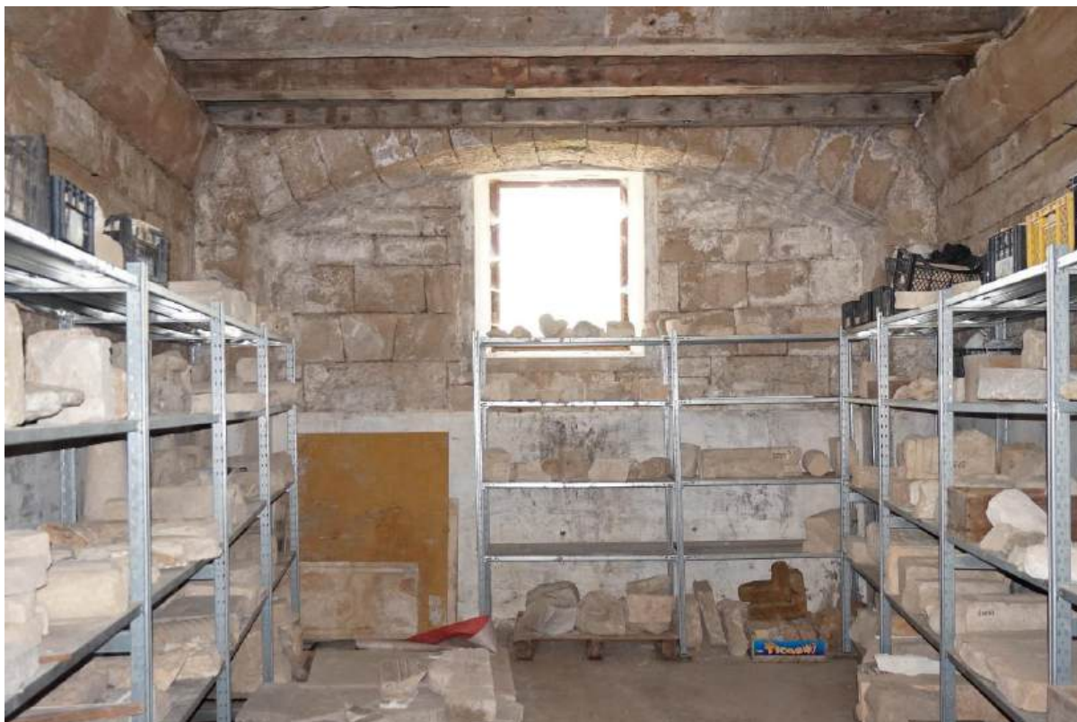
Sl. 7.19. Prizemlje, prostorija 18. Pogled na vanjski zid.
