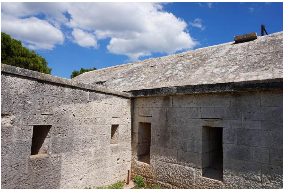
Sl. 7.254. Pogled na spoj sjevernog zida untarnjeg dvorišta i istočnog kaponira.
