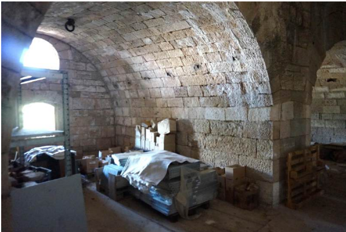
Sl. 7.128. Kat, prostorija 2. Pogled u smjeru vanjskog zida.
