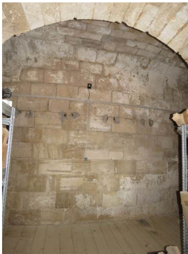
Sl. 63 Pogled na recentno montirane električne instalacije.
