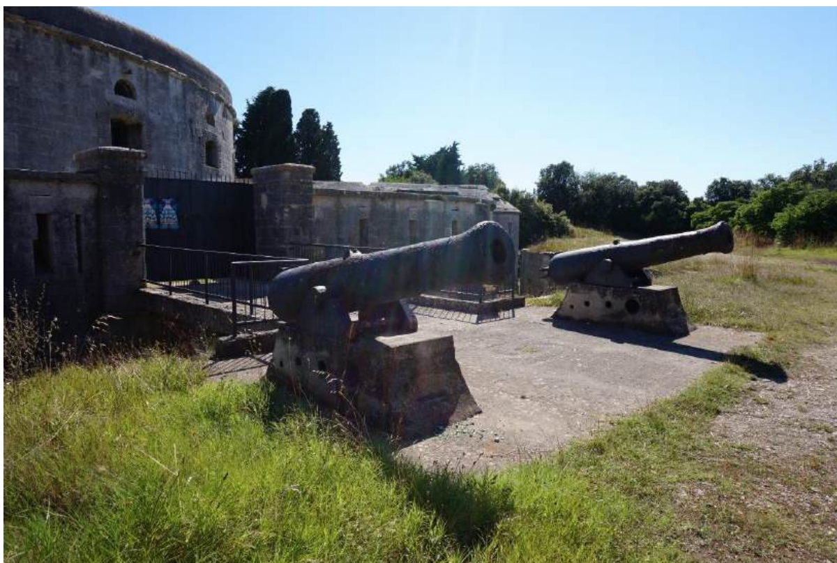
Sl. 7.259. Pogled sa sjeveroistoka na ulazni portal.
