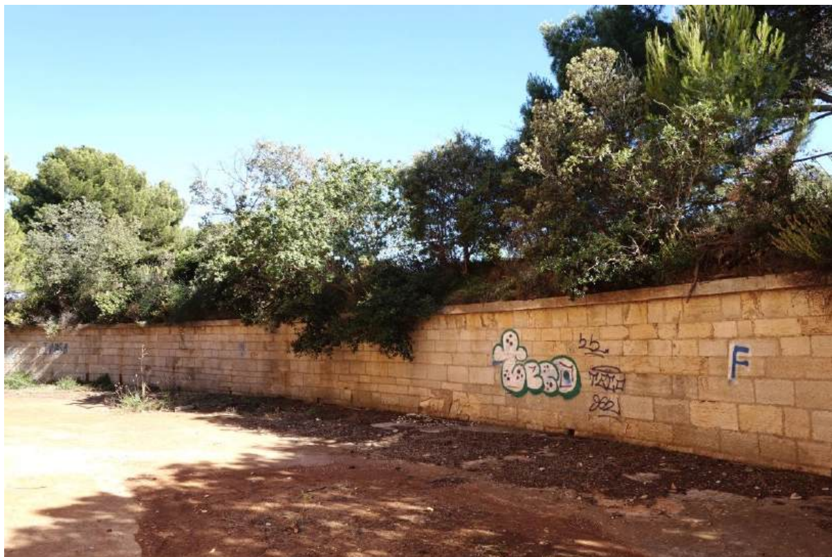
Sl. 7.235. Pogled na južni dio zida kontraeskarpu u južnom opkopu.
