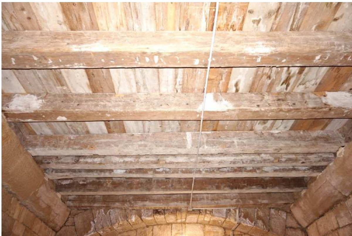
Sl. 7.17 Prizemlje, prostorija 19. Pogled na međukatnu drvenu konstrukciju.
