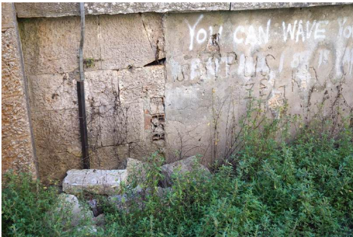
SI. 5.227. Pogled na južno pročelje. Puškarnice kazamata u prizemlju.
