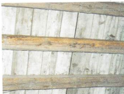
Sl. 184 Drveni strop.
