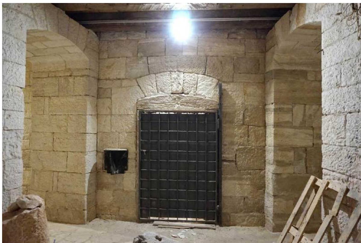
Sl. 7.37. Prizemlje, prostorija 10. Pogled na unutarnji zid i ulaz u prostoriju 25.
