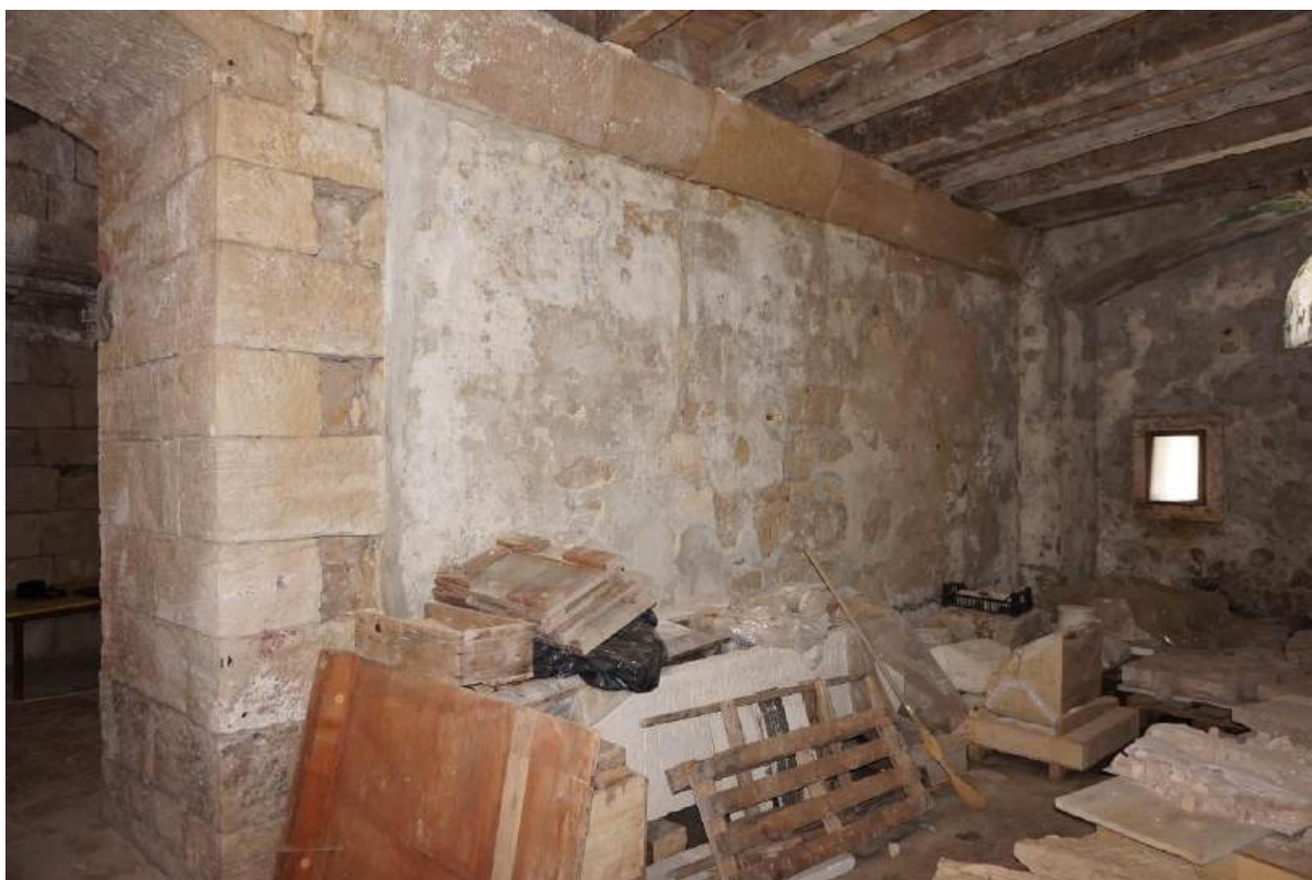
Sl. 7.9. Prizemlje, prostorija 20. Pogled na zid između prostorija 20 i 1.
