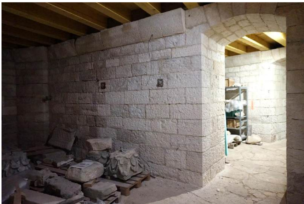
Sl. 7.47. Prizemlje, prostorija 8. Pogled na zid između prostorija 8 i
