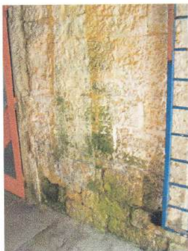
Sl. 21, 22 Kolonija algi na zidu desno i lijevo uz prolaz prema dvorištu.
