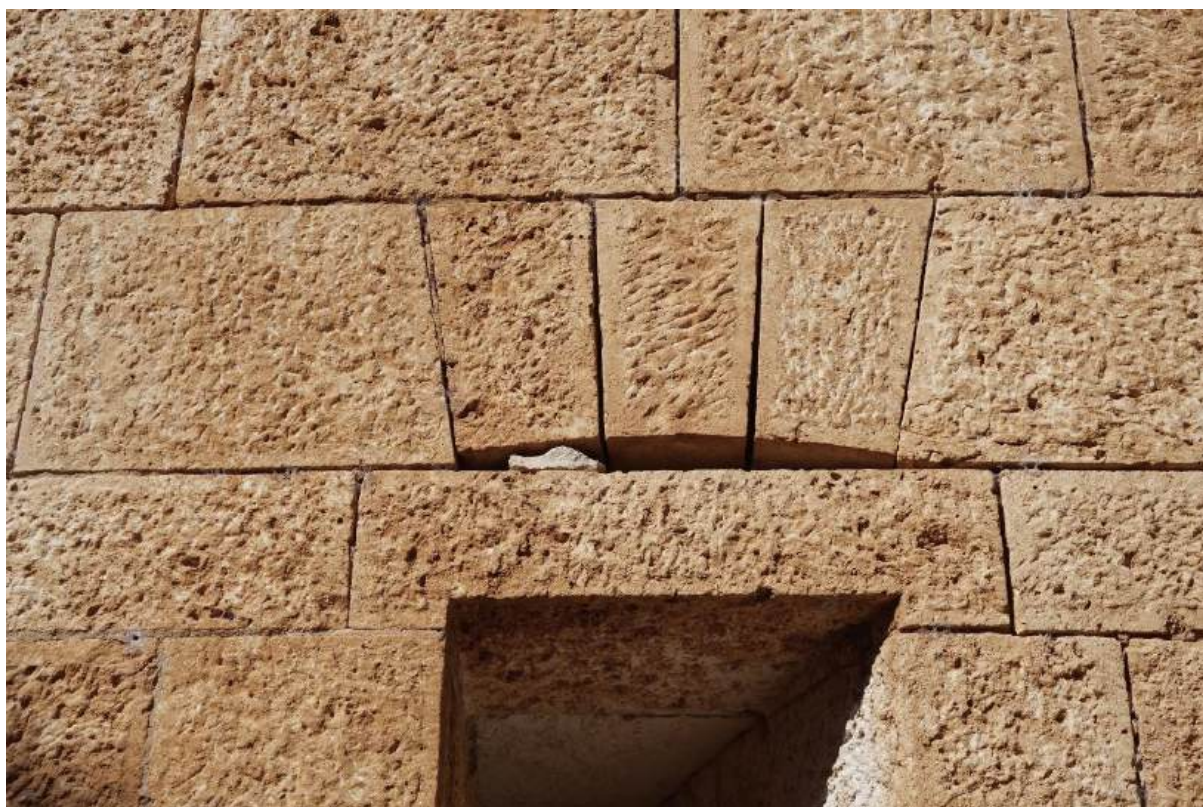
SI. 7.237. Južno pročelje. Nadvoj ambrazure kazamata u prizemlju.
