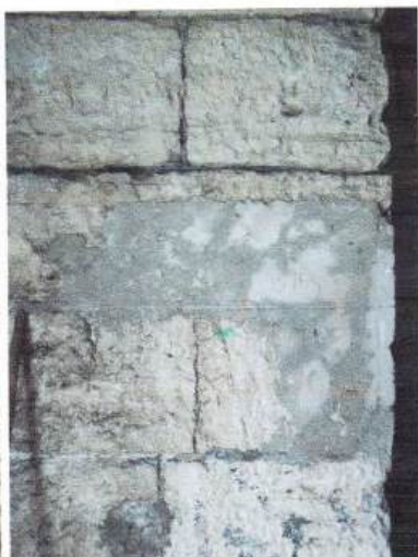
Sl. 3-4 Primjer cementnih zakrpa uz ulazni prolaz.
