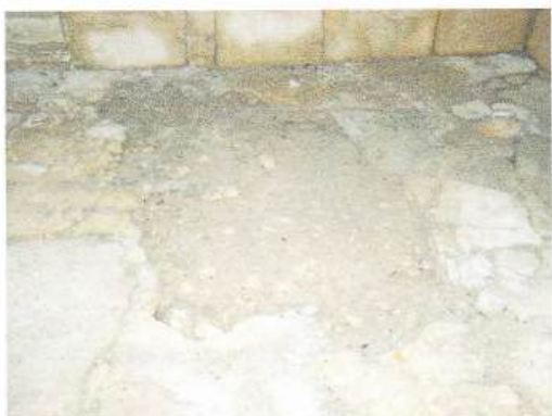
Sl. 67 Cementna zakrpa poda.
