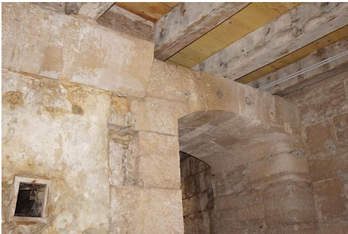
Sl. 7.13. Prizemlje, prostorija 20. Pogled na otvor između prostorija 20 i 19.
