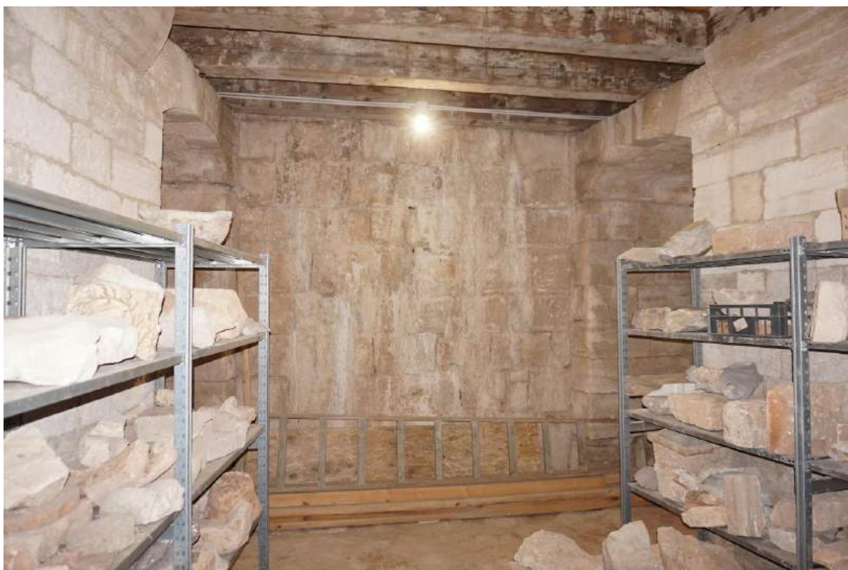
Sl. 7.23. Prizemlje, prostorija 1 Pogled na unutarnji zid.
