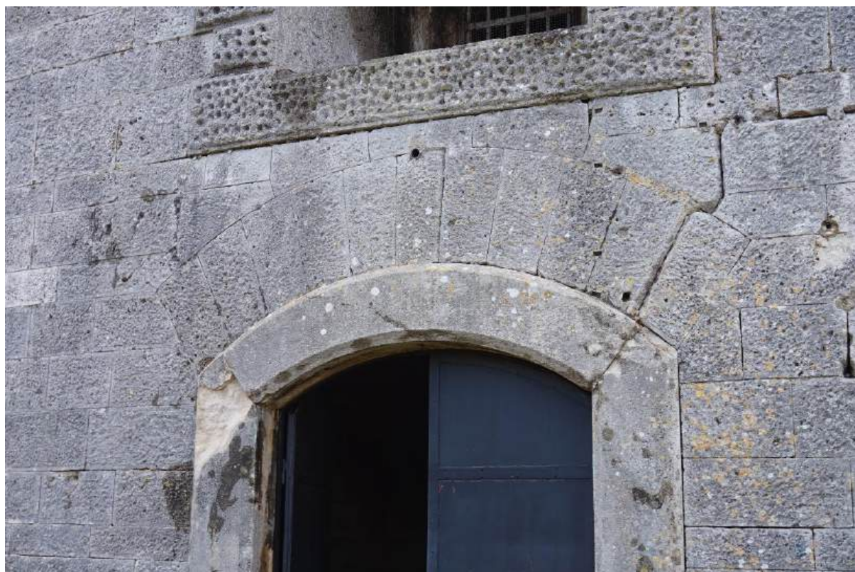
SI. 7.245. Ulaz u utvrdu. Detalj nadvoja i oteretnog luka nad otvorom.
