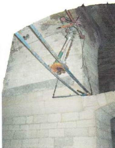
Sl. 70 Željezna instalacija.
