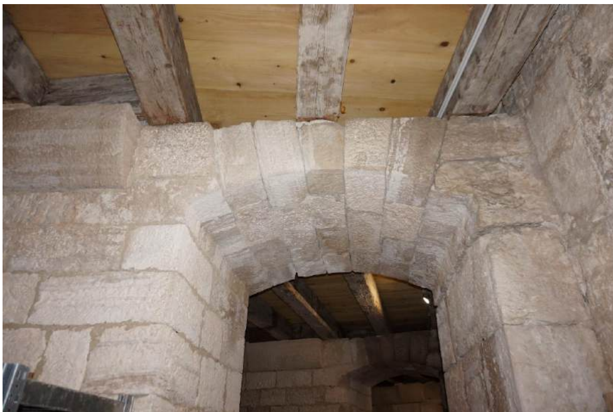
Sl. 7.24. Prizemlje, prostorija 1 Pogled na otvor prema prostoriji 16.
