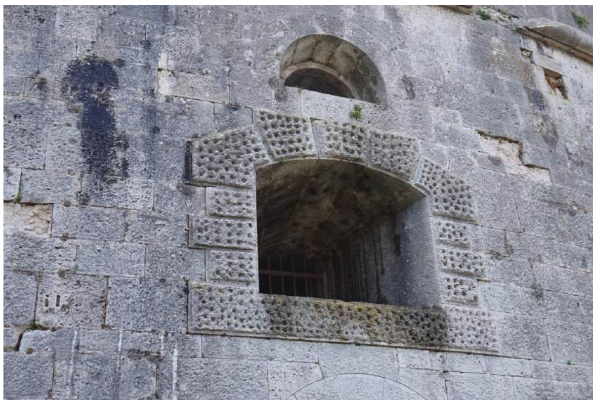
Sl. 7.248. Ambrazura i polukružni otvor za ventilaciju kazamata 19 na katu utvrde, sjeverno pročelje.
