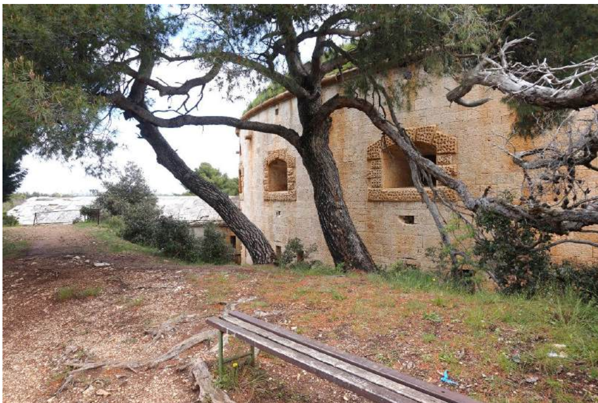
Sl. 7.287. Okoliš neposredno uz utvrdu, pogled prema zapadnom kaponiru.
