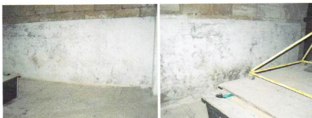
Sl. 46, 47 Cementnim mortom ožbukani prizemni dio prostorije.
