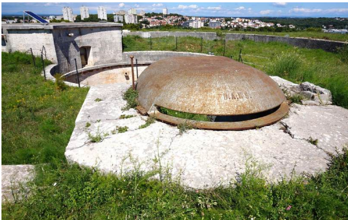
Sl. 7.165. Pogled prema sjeveru. Lijevanoželjezna kupola na osmatračnici.
