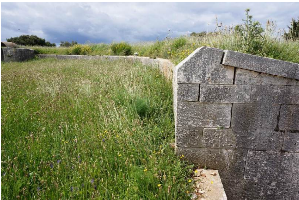
Sl. 7.157. Zapadni kraj prosobrana krovne terase na spoju s gornji ophodom.
