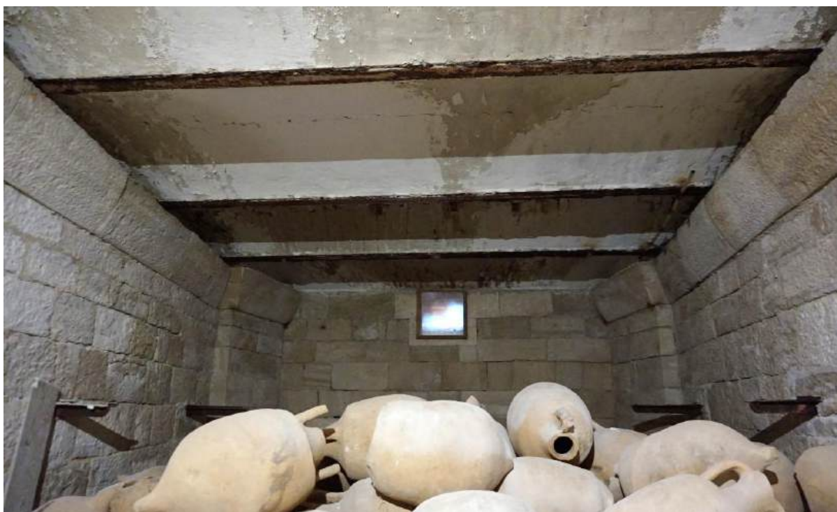
Sl. 7.50. Prizemlje, prostorija 6. Pogled na vanjski zid.
