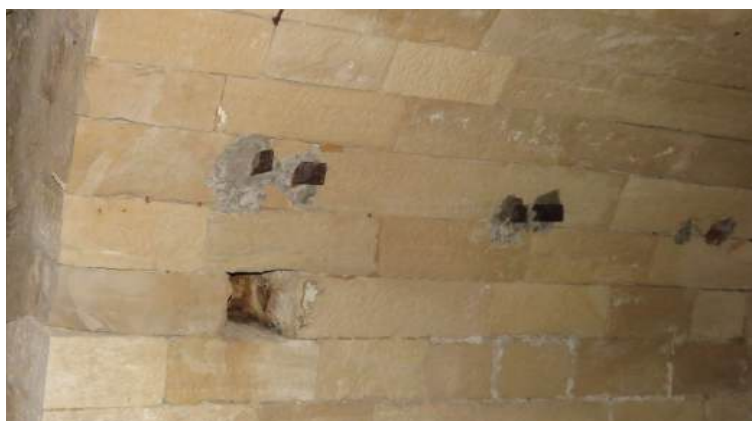
Sl. 62 Detalj naknadno ugrađenih elemenata u kamen unutarnjih zidova utvrde.
