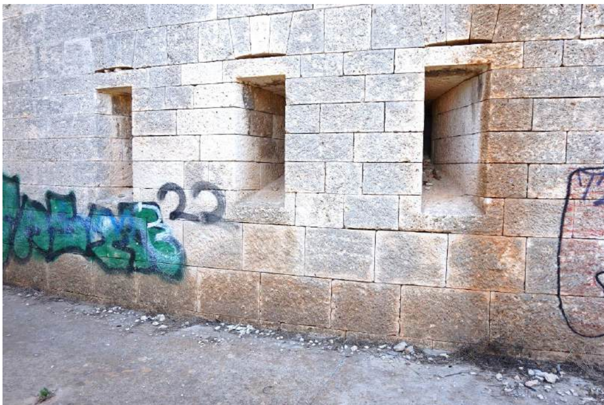
Sl. 7.218. Pogled na sjeverno pročelje. Ambrazure kazamata u prizemlju.
