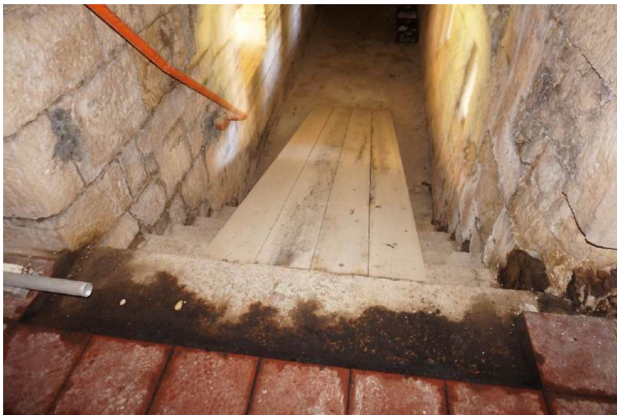
Sl. 7.70. Prizemlje, zapadni kaponir (prostorija 28). Stubište prema galeriji u kontraeskarpi.
