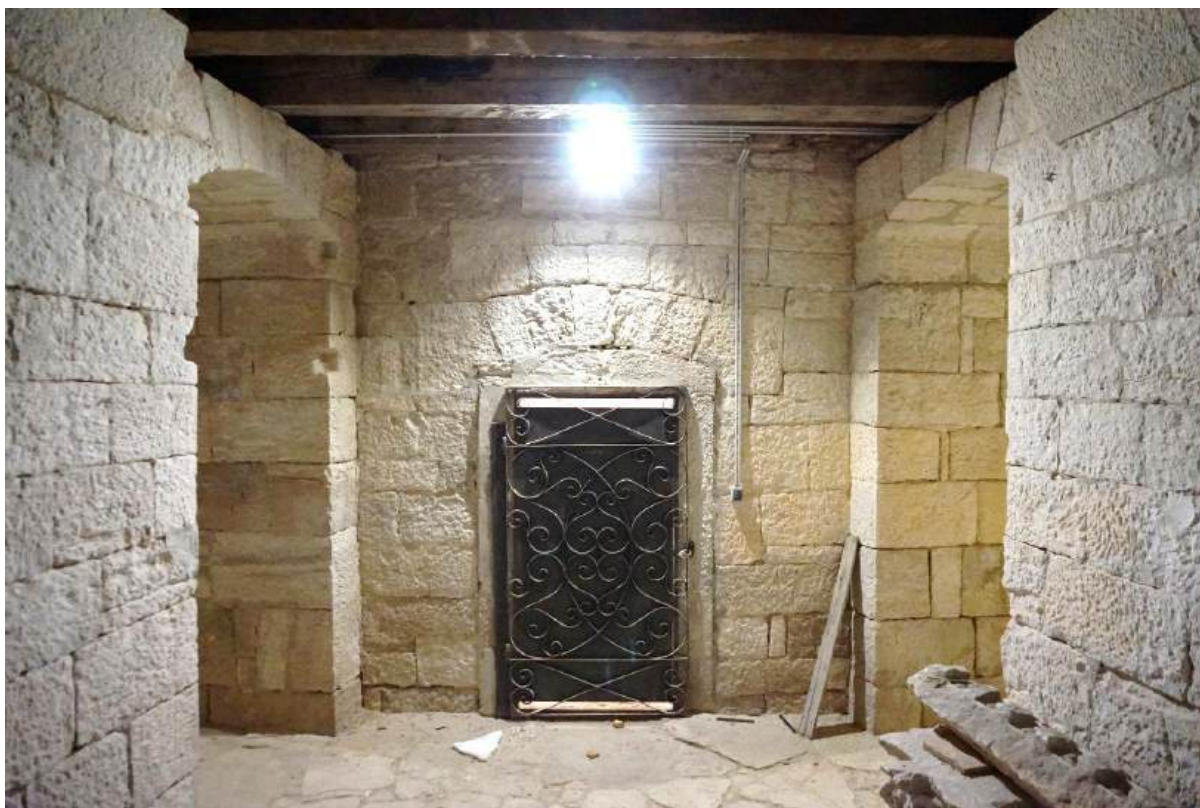
Sl. 7.33. Prizemlje, prostorija 12. Pogled na unutarnji zid i ulaz u prostoriju 25.
