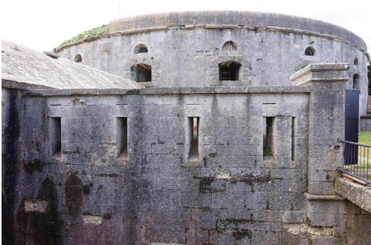
Sl. 7.250. Istočni dio obrambenog zida vanjskog dvorišta. Pogled sa sjevera.
