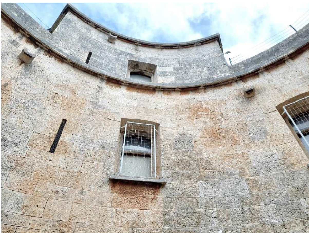
Sl. 7.175. Unutarnje dvorište, pogled prema sjeveru, kat i krovna kućica.
