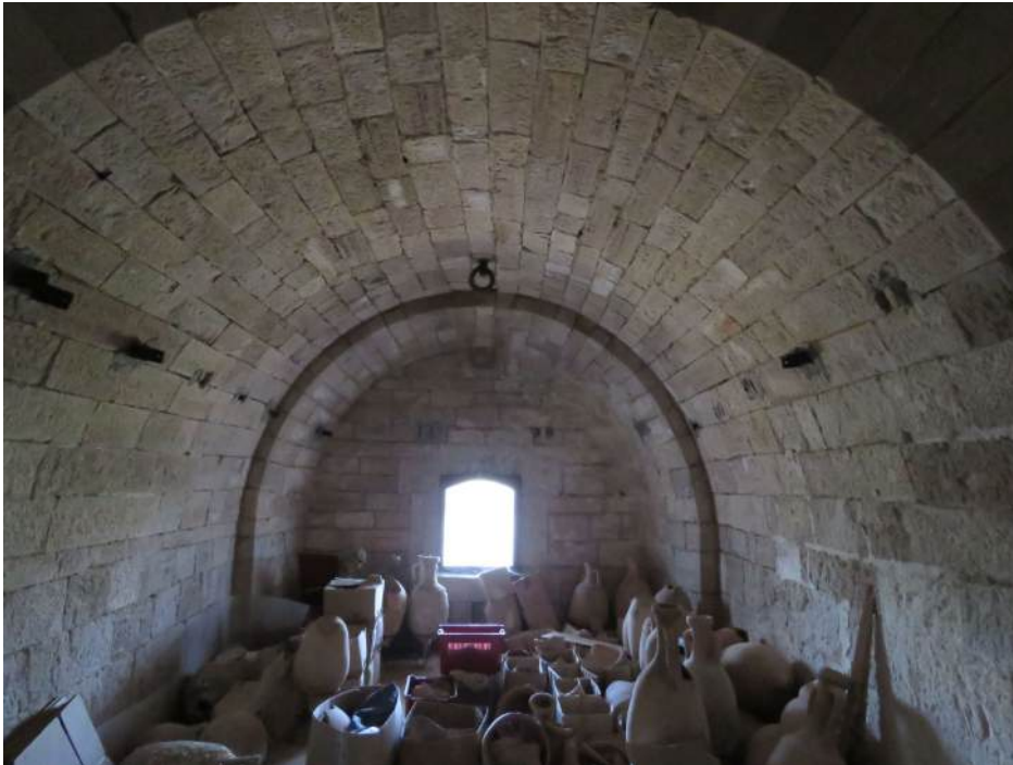
Sl. 59 Pogled unutar jedne koncentrične prostorije prvog kata s vidljivim mnogobrojnim željeznim elementima izvorno i naknadno ugrađenim u kamen zidova.
