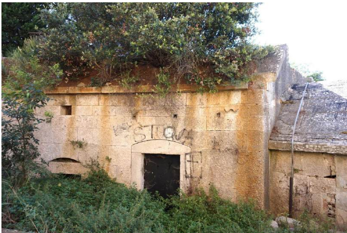
Sl. 7.225. Pogled na zapadnu galeriju u kontraeskarpi. Vrata za ulaz u galeriju.
