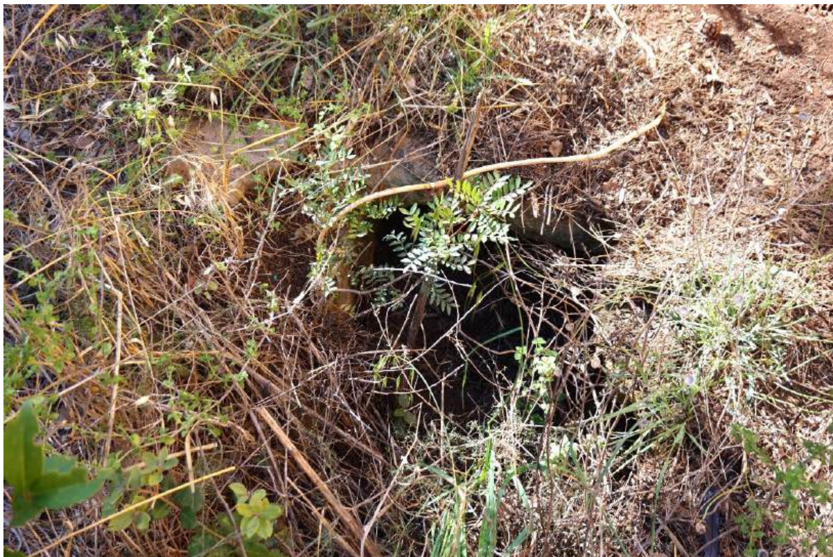
Sl. 7.232. Otvor kanala za odvodnju u opkopu.
