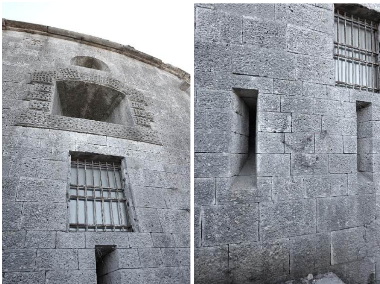
Sl. 7.216.a, b Pogled na južno pročelje. Ambrazure kazamata u prizemlju.
