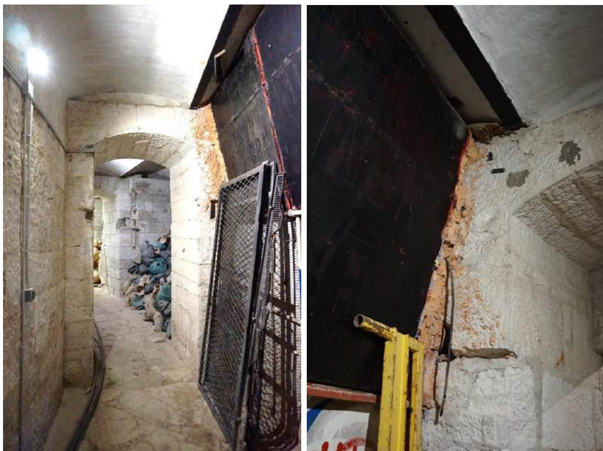
Sl. 7.59.a, b Prizemlje, prostorija 4. Pogled na otvor prema prostoriji 5 (lijevo); Pogled na nadvoj u zidu između prostorija 4 i 3.
