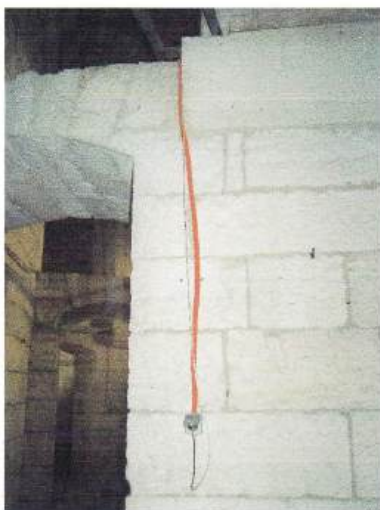
Sl. 73 Instalacije struje.
