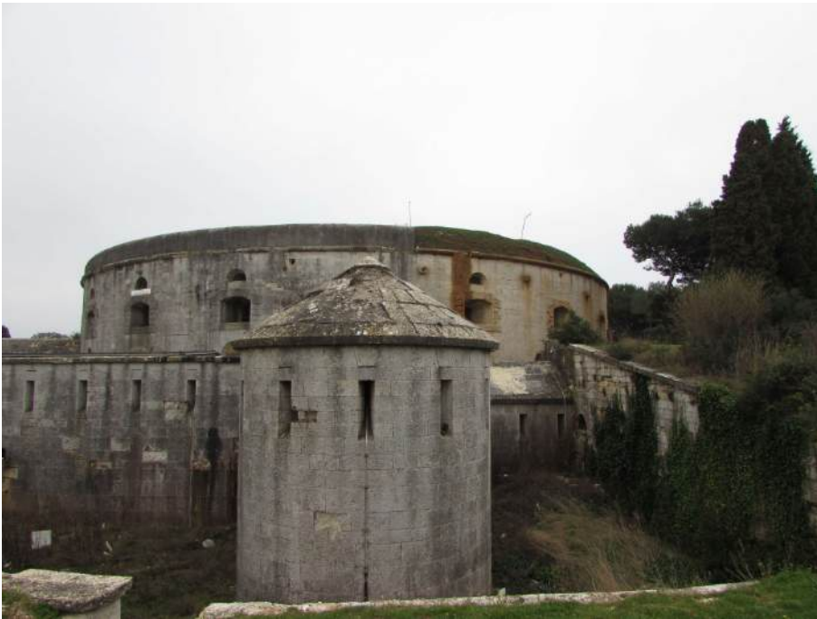
Sl. 36 Pogled na utvrdu s jasnim prijelazom između istočne i zapadne strane. Na istočnoj su strani prisutne široke kolonije biološkog obraštaja karakterizirane sivom bojom površina, dok su površine prema zapadu prekrivene depozitima.
