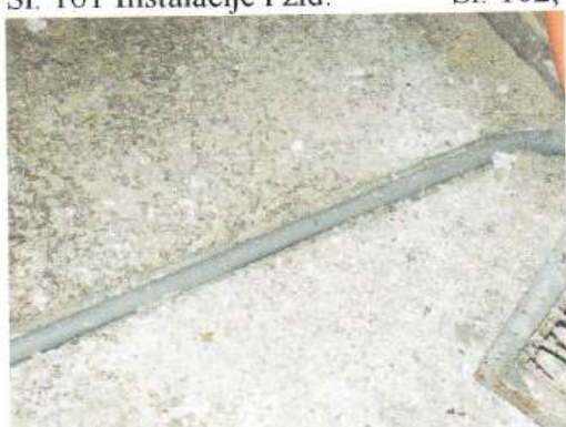
Sl. 164 Cementni pod s instalacijama.
