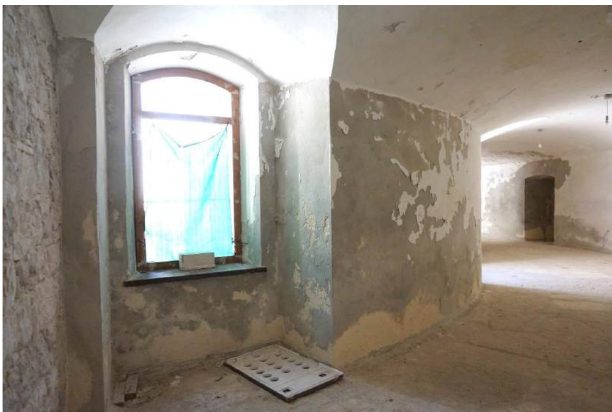
Sl. 7.104. Prizemlje, prostorija 25. Pogled na prozor prema unutarnjem dvorištu.
