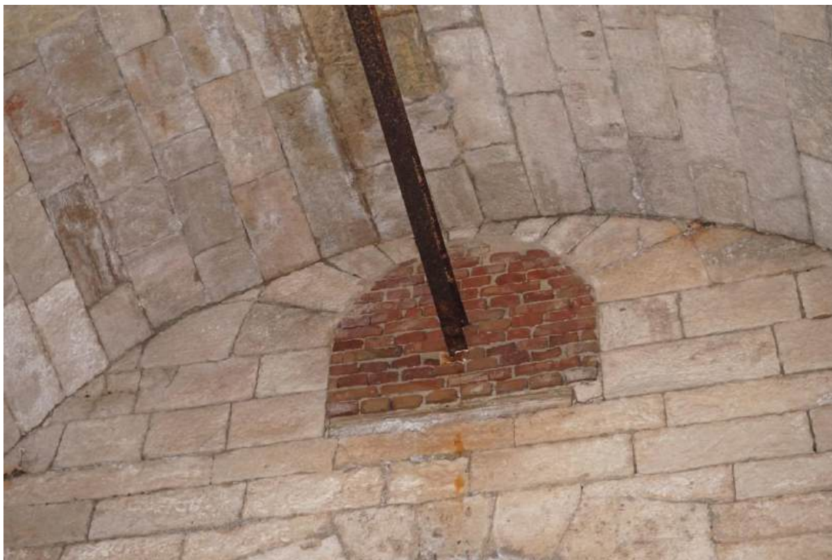
SI. 7.4. Prizemlje, prostorija 1. Zazidani izvorni otvor za ventilaciju kazamata u zoni kata.
