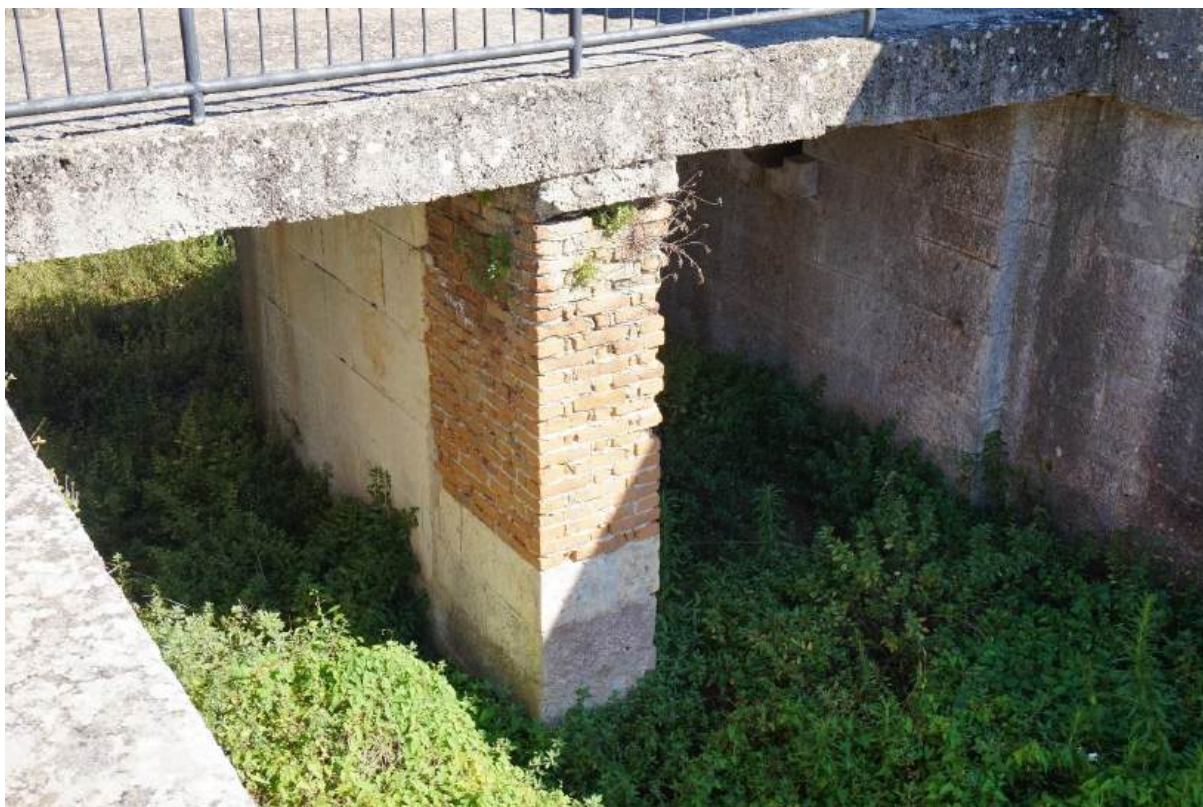
Sl. 7.260. Pogled na potporanj mosta
