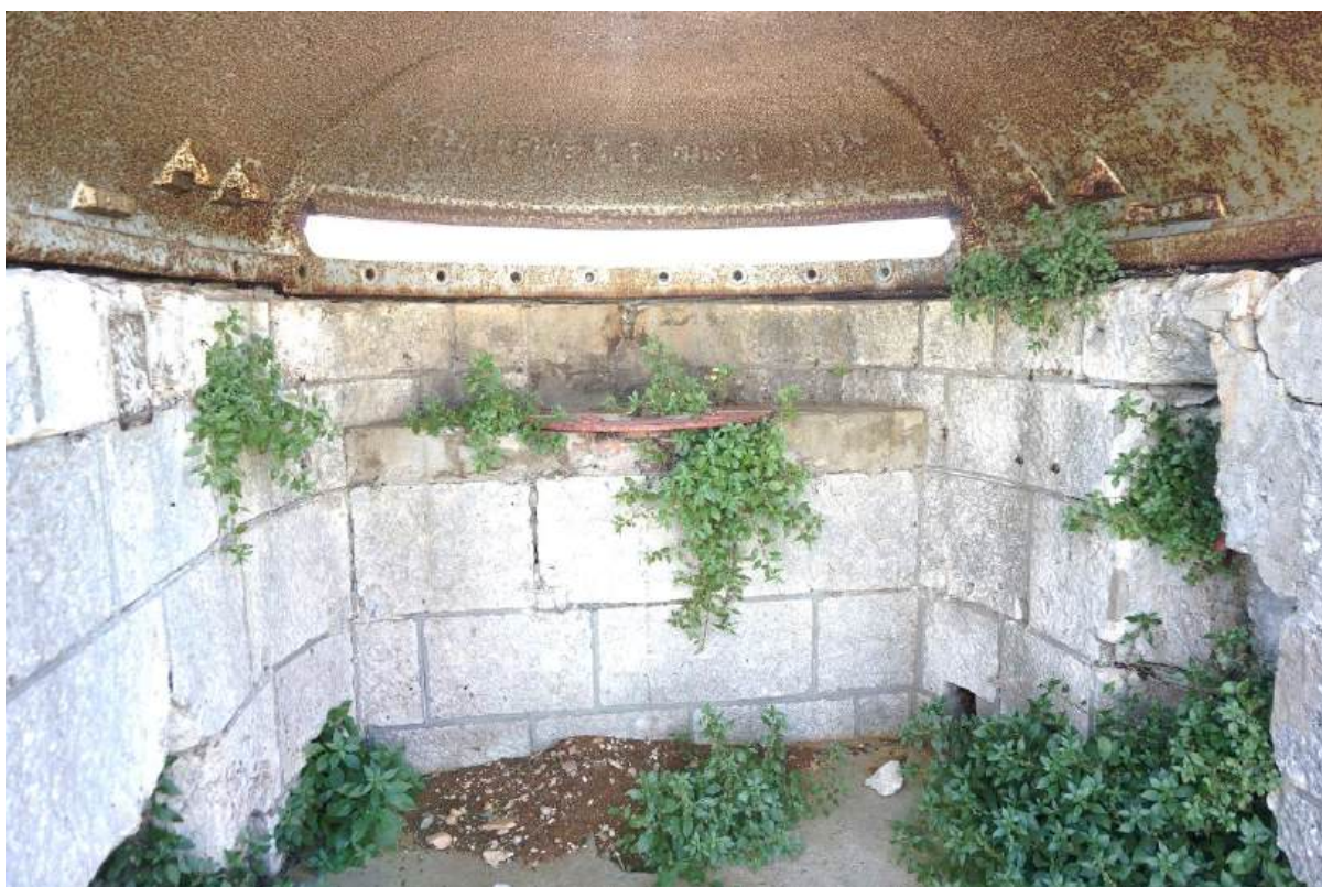
Sl. 7.166. Lijevanoželjezna kupola, pogled na unutrašnjost.
