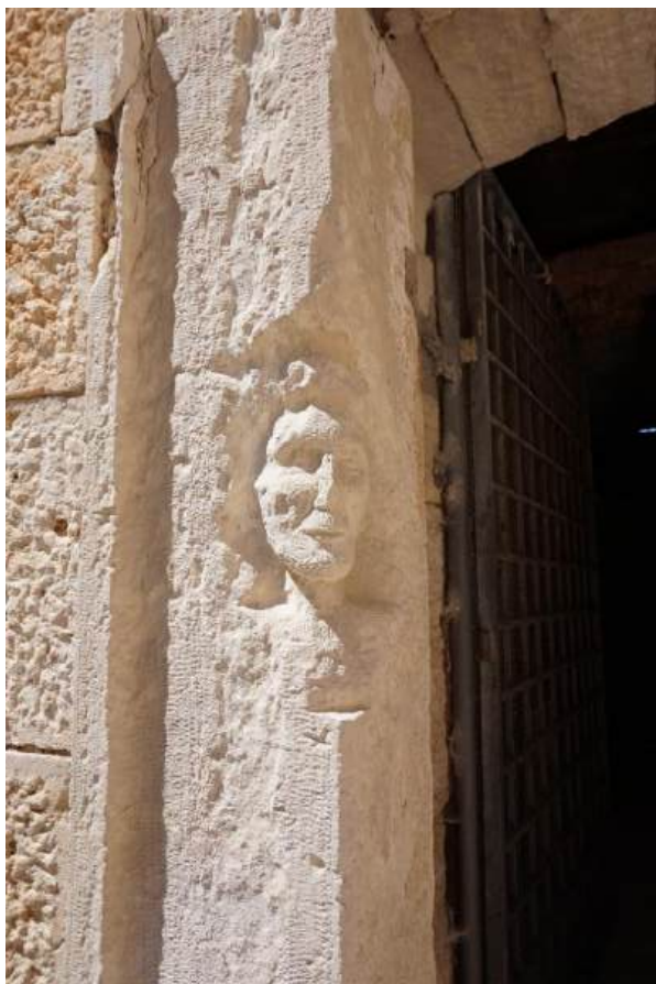
Sl. 7.183.a, b Unutarnje dvorište, pogled prema sjeveru. Glavni ulazni portal u dvorište. Oštećenja bočnih kamenih erti nastala „umjetničkom intervencijom“.
