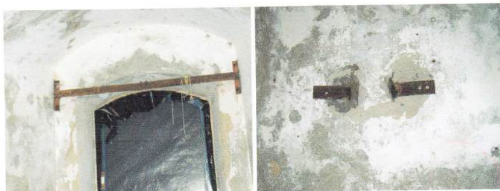
Sl.193, 194 Detalji željeznih elemenata.
