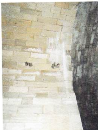
Sl. 48, 49 Svod prostorije sa vidljivim smjerom curenja vode i željeznim nosačima vjerojatno iz druge faze korištenja prostorije.
