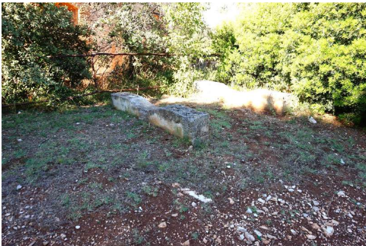
Sl. 7.283. Pogled na betonsku konstrukciju uz ogradu na južnoj glasiji.
