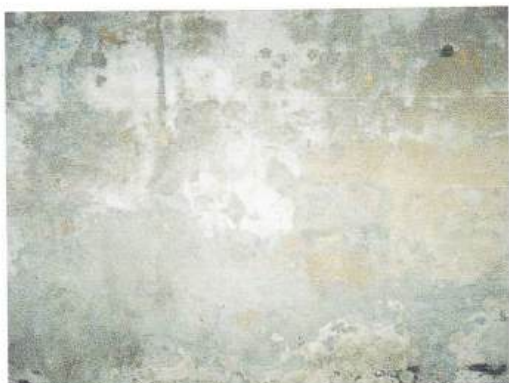
Sl. 27, 28 Cementnim mortom ožbukani prizemni dio prostorije 2.
