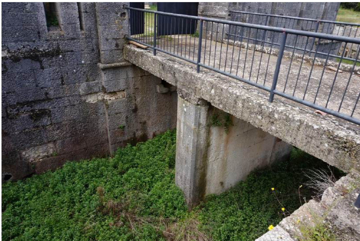
Sl. 7.249. Ulazni most nad opkopom, pogled s istoka.
