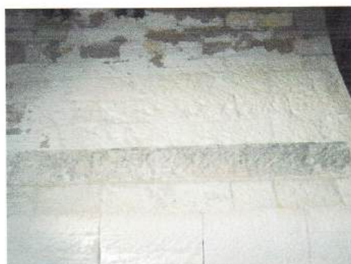
Sl. 69 Originalni vapneni premaz.
