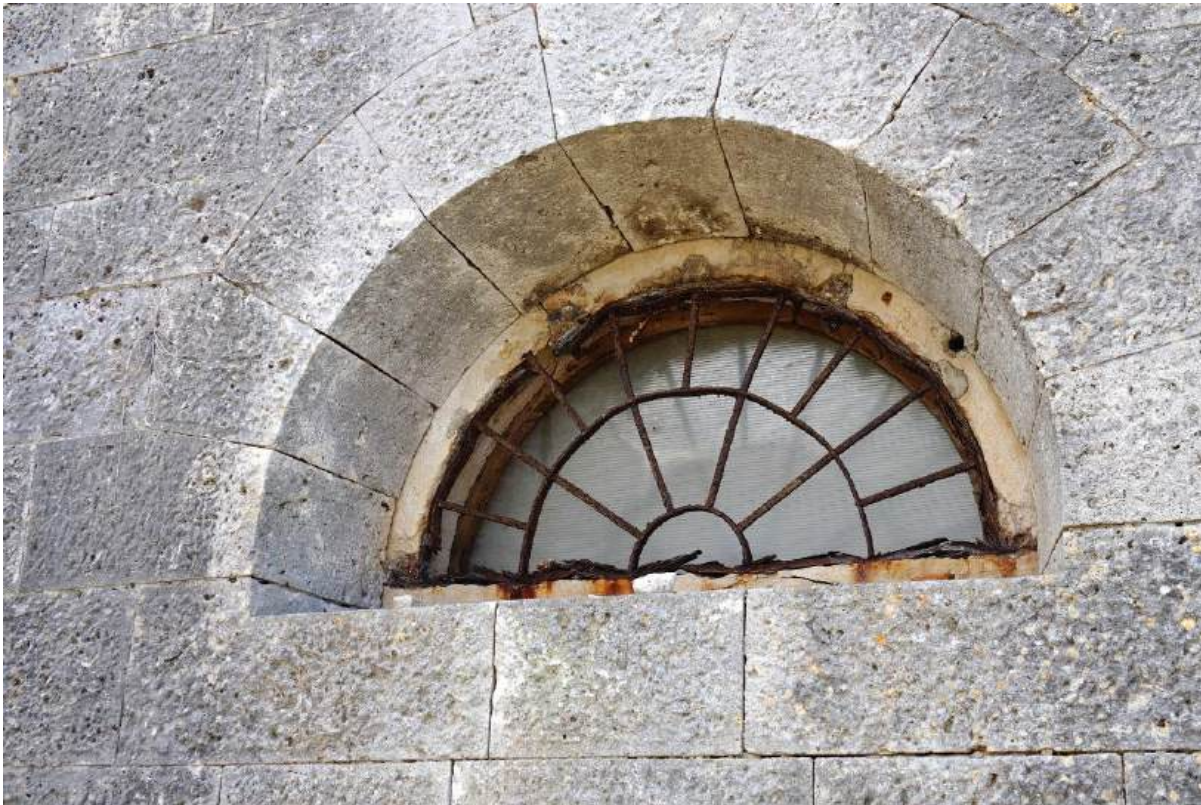
Sl. 7.265. Pogled na polukružni otvor s izvornom metalnom rešetkom na sjevernom pročelju.
