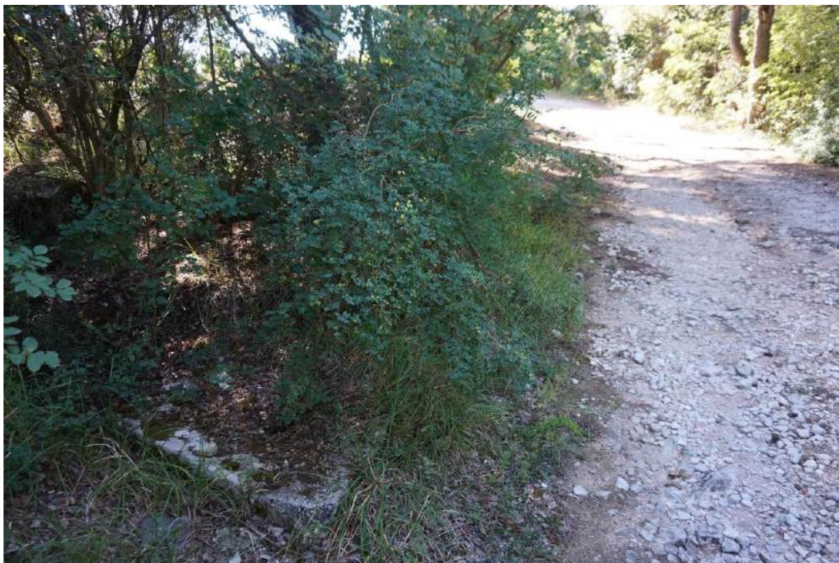
Sl. 7.269. Pogled na povijesni makadamski put i kamenu rešetku odvodnog kanala.
