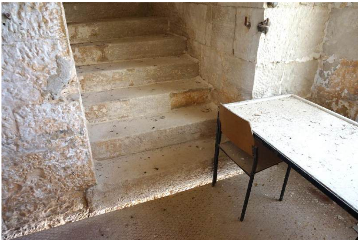
Sl. 7.114. Kat, prostorija 22. Pogled na krak stubišta za drugi kat / krovnu terasu.
