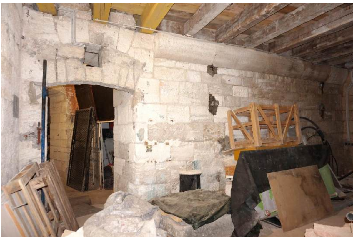
Sl. 7.62. Prizemlje, prostorija 3. Pogled na zid između prostorija 3 i 4.
