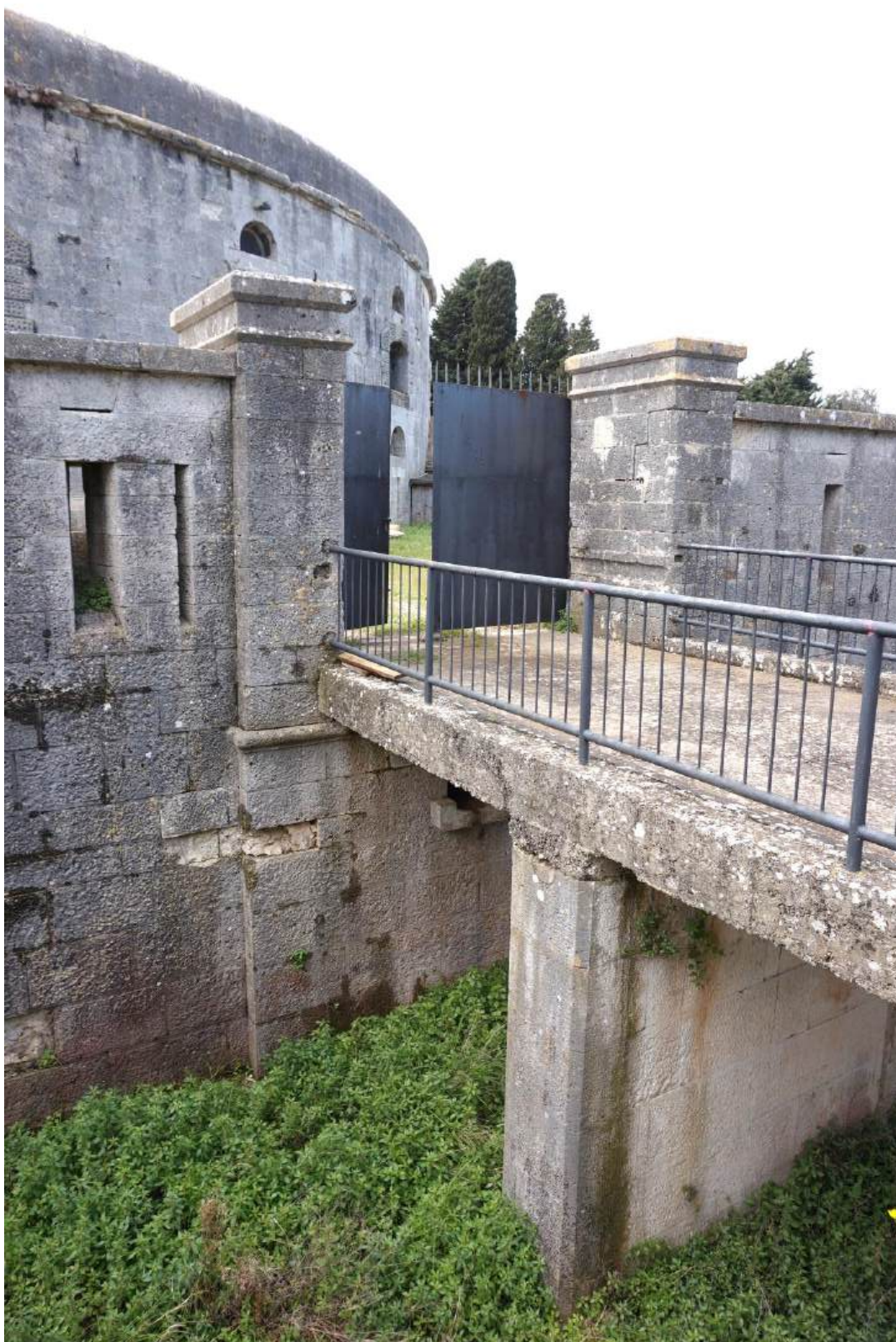
Sl. 7.251. Ulazni most nad opkopom i ulazni portal s dvokrilnim vratima u vanjsko dvorište.
