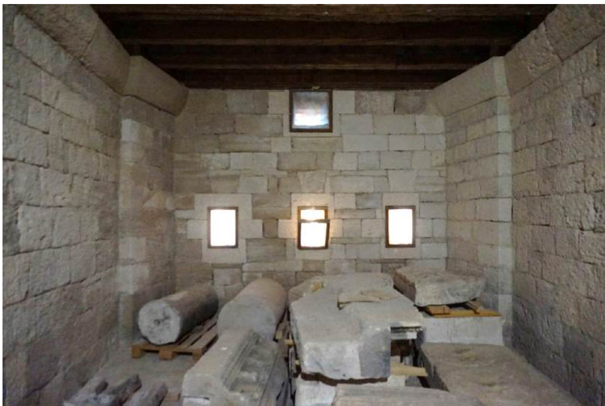
Sl. 7.34. Prizemlje, prostorija 11. Pogled na vanjski zid.
