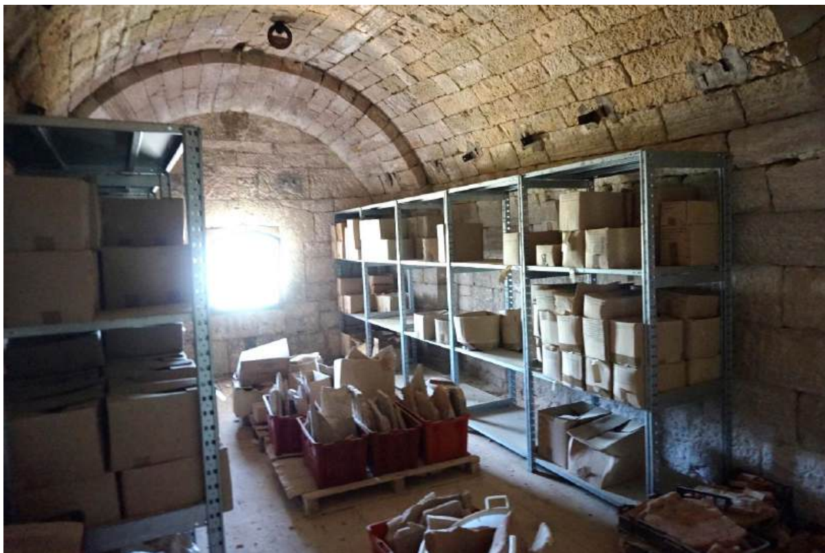
Sl. 7.134. Kat, prostorija 6. Pogled u smjeru vanjskog zida.
