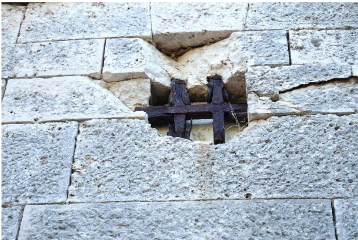
Sl. 7.239. Rešetka na izlazu ventilacijskog otvora na pročelju kazamata u prizemlju.
