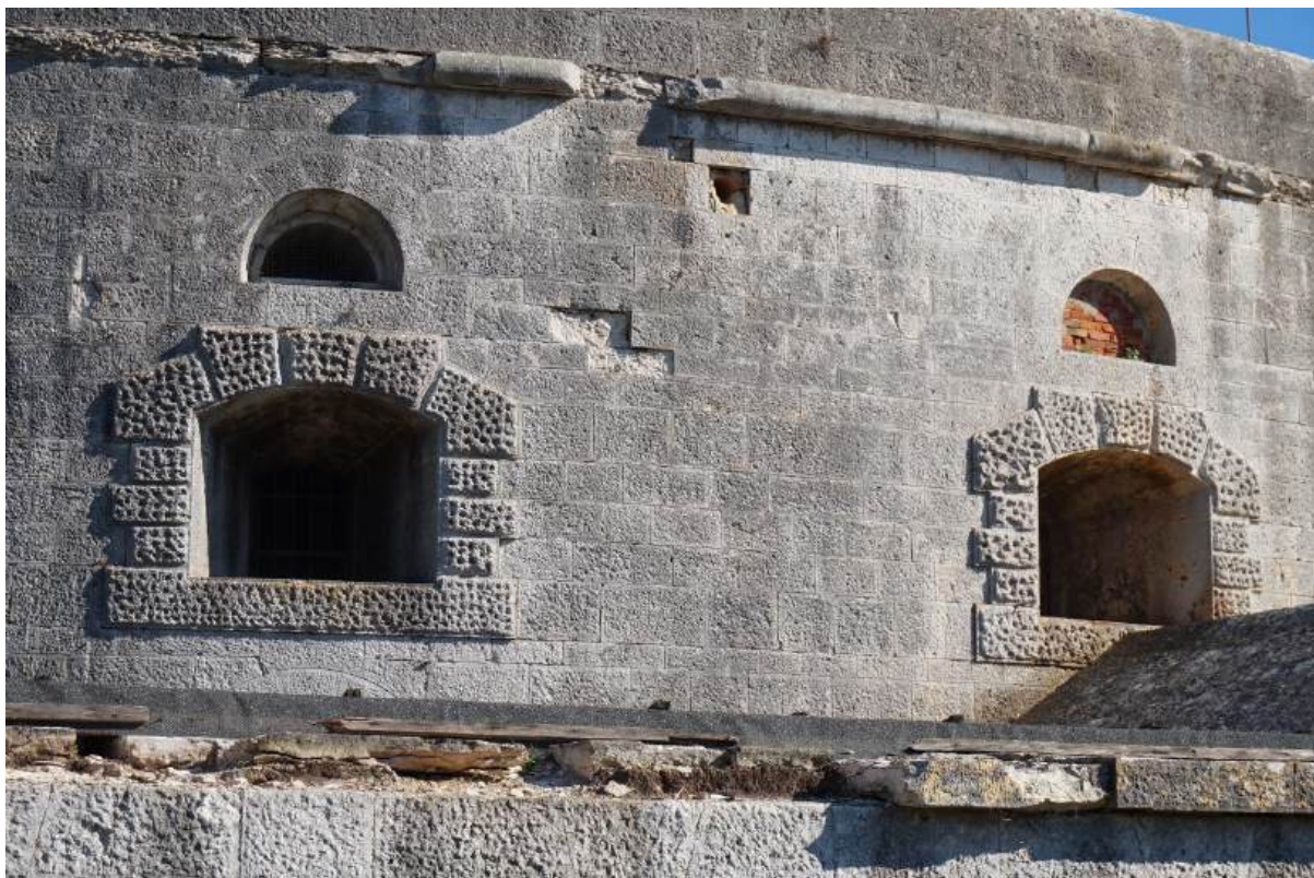
SI. 7.202. Pogled na spoj zapadnog kaponira sa utvrdom na zapadnom pročelju u obrambenom rovu.
