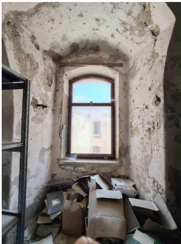
Sl. 6 – primjer “novije” intervencije
