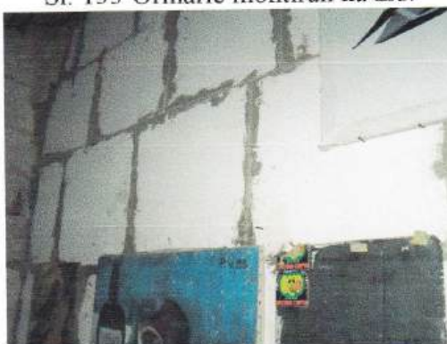
Sl. 135 Pregradni zid iz siporexa.
