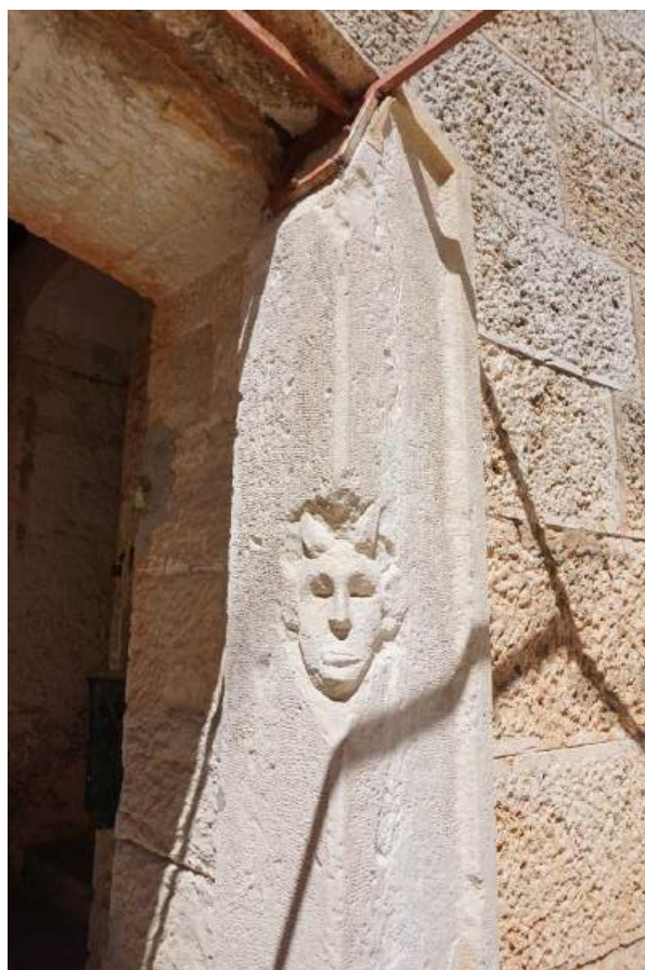
Sl. 7.183.a, b Unutarnje dvorište, pogled prema sjeveru. Glavni ulazni portal u dvorište. Oštećenja bočnih kamenih erti nastala „umjetničkom intervencijom“.
