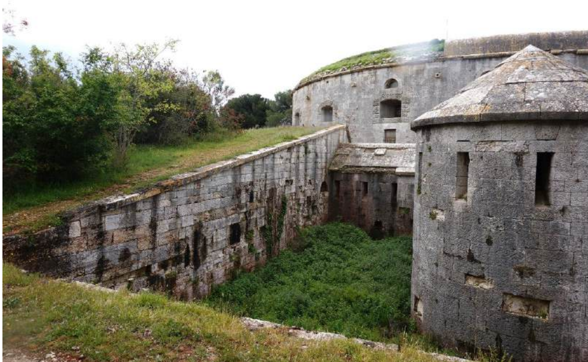
Sl. 7.193. Pogled sa sjevera na istočni dio sjevernog opkopa s kontraeska i istočni kaponir.
