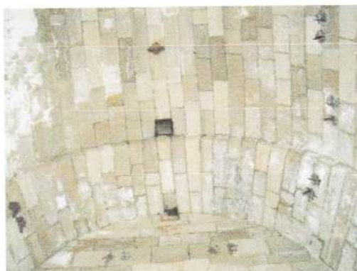
Sl. 87 Svod prostorije, vidljivi su željezni nosači
