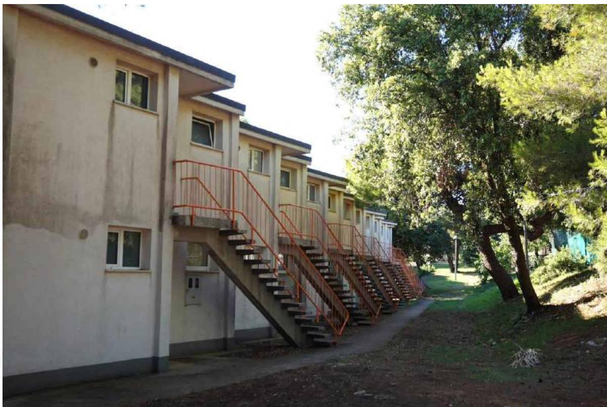
Sl. 7.292. Sjeverno pročelje građevine u apartmanskom naselju, na međi kulturnog dobra.
