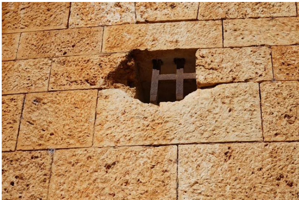
Sl. 7.215. Južno pročelje. Rešetka na ventilacijskom otvoru kazamata prizemlja.
