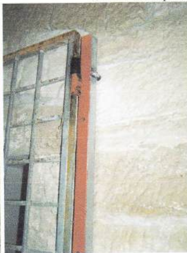
Sl. 90, 91 Vrata prema prostoriji 22, detalj montaže u kamene blokove.
