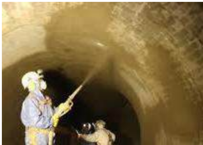
Prikaz primjene hidroizolacije OMBRAN ASP i završni izgled površine koja bi bila ispod kamenih podnih obloga
