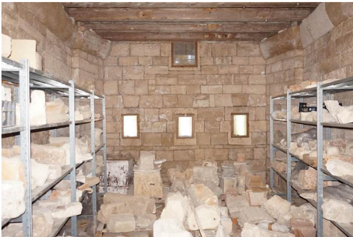
Sl. 7.22. Prizemlje, prostorija 1 Pogled na vanjski zid.
