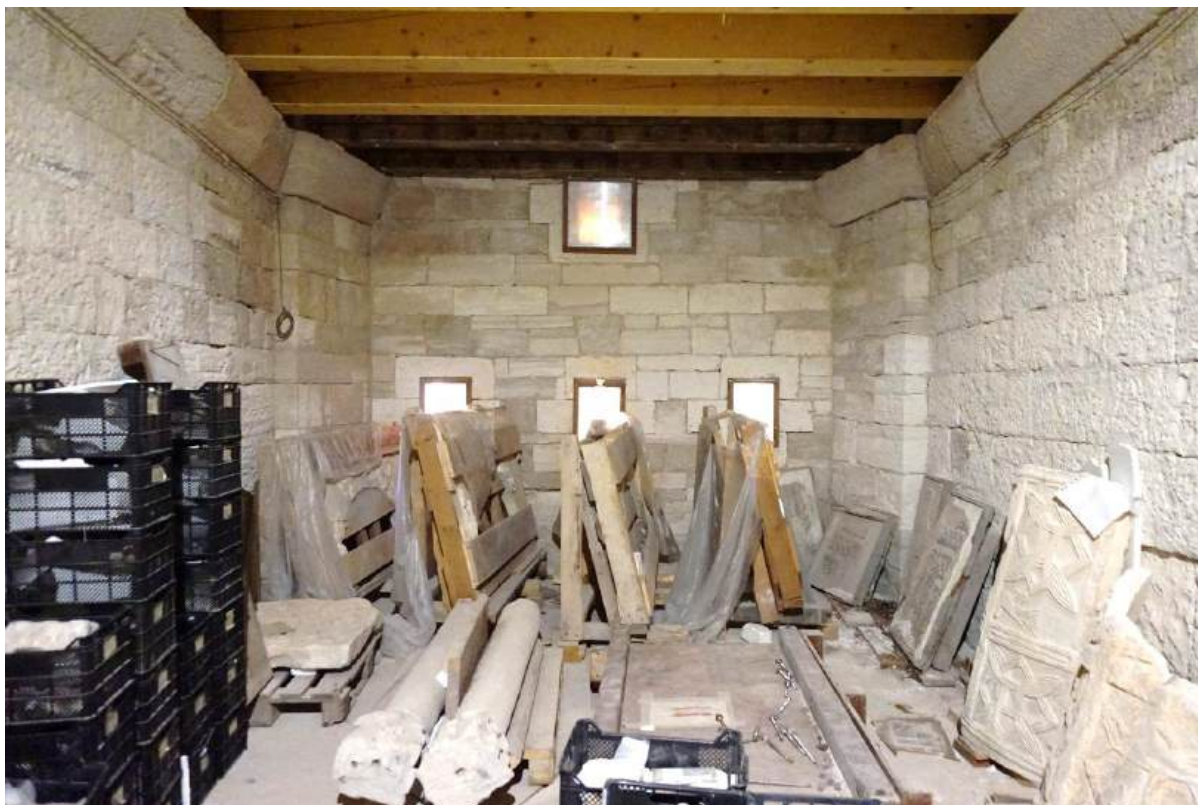
SI. 7.40. Prizemlje, prostorija 9. Pogled na vanjski zid.
