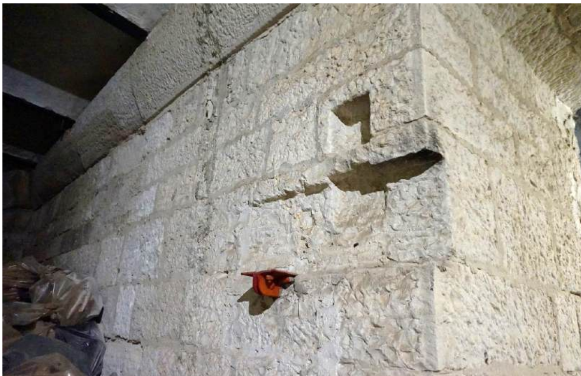
Sl. 7.56. Prizemlje, prostorija 5. Pogled na zid između prostorija 5 i 4.
