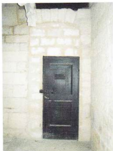
Sl. 98, 99, 100 Pregrađen prolaz prema prostoriji 14 sa ugrađenim vratima, vrata na gornjem katu.
