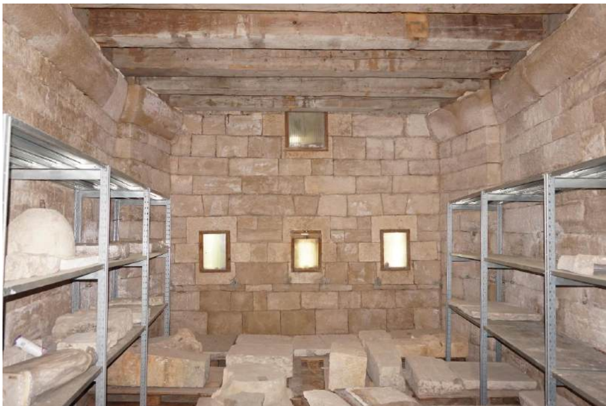
Sl. 7.26. Prizemlje, prostorija 16. Pogled na vanjski zid.
