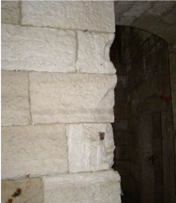
Sl. 75 Uglovi kamenih blokova u unutrašnjosti utvrde odlomljeni mehaničkom aktivnošću.
