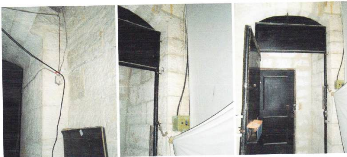
Sl. 104, 105, 106 Detalji vrata i instalacija struje.
