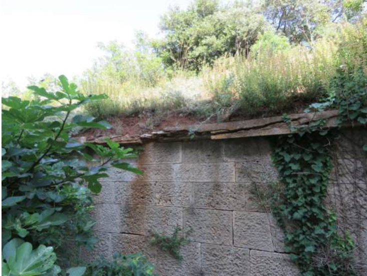
Sl. 85 Primjer višeg bilja na zidu koji podržava vanjski nasip.
