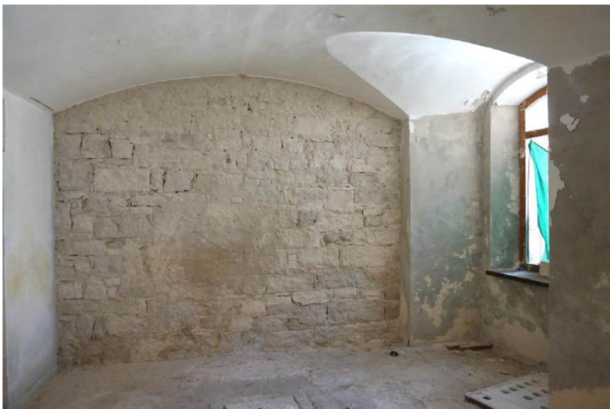
Sl. 7.103. Prizemlje, prostorija 25. Pogled na zapadni kraj prostorij s prozorom prema unutarnjem dvorištu.
