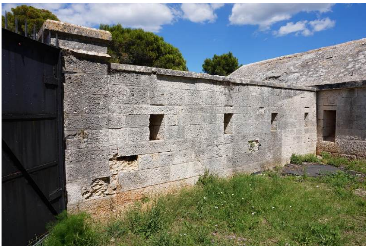
Sl. 7.253. Pogled na istočno dio obrambenog zida iz vanjskog dvorišta.
