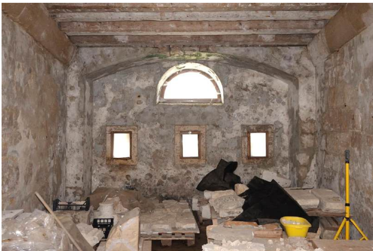
Sl. 7.10. Prizemlje, prostorija 20. Pogled na vanjski zid.
