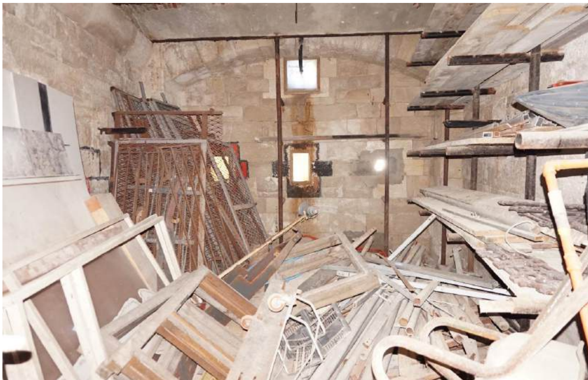
Sl. 7.58. Prizemlje, prostorija 4. Pogled na vanjski zid.
