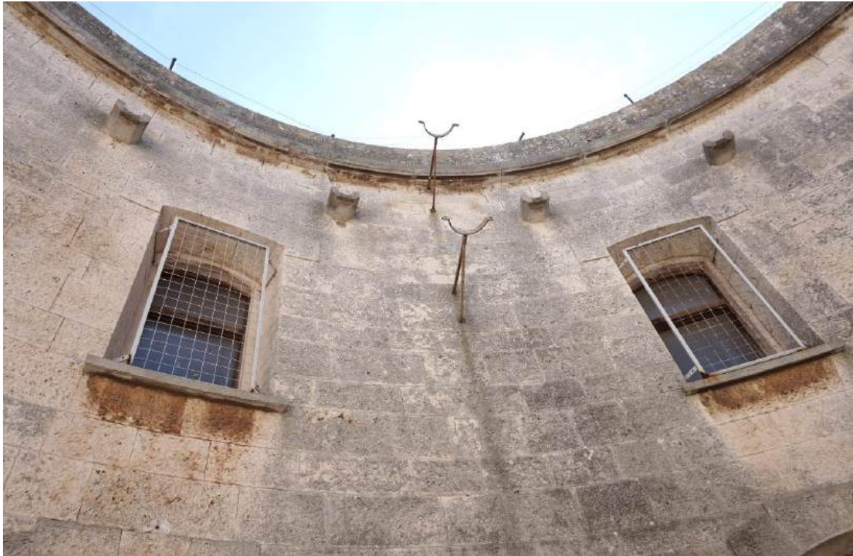
Sl. 7.176. Unutarnje dvorište, pogled prema jugu na prozorske otvore kata.
