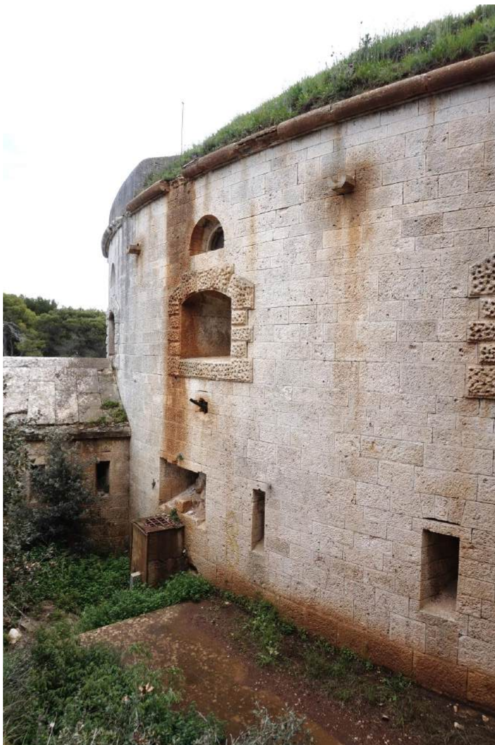
Sl. 7.204. Pogled na zapadno pročelje.
