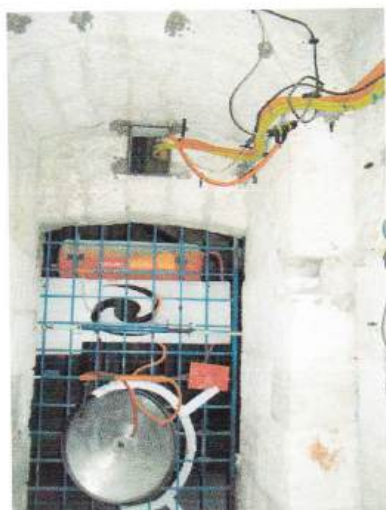
Sl. 141 Vrata i instalacije.
