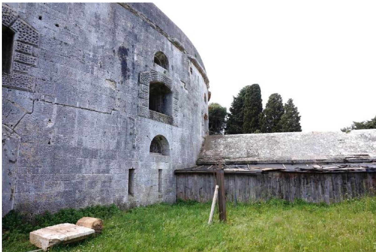
Sl. 7.241. Vanjsko dvorište, pogled prema zapadu.
