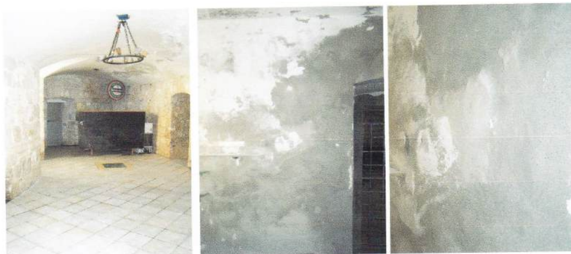
Sl. 169, 170, 171 Pod i detalji zidova.
