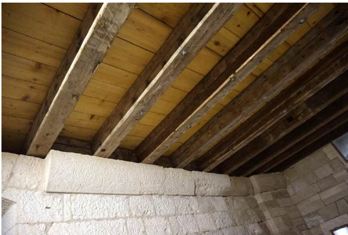
Sl. 7.31. Prizemlje, prostorija 13. Pogled na međukatnu konstrukciju.
