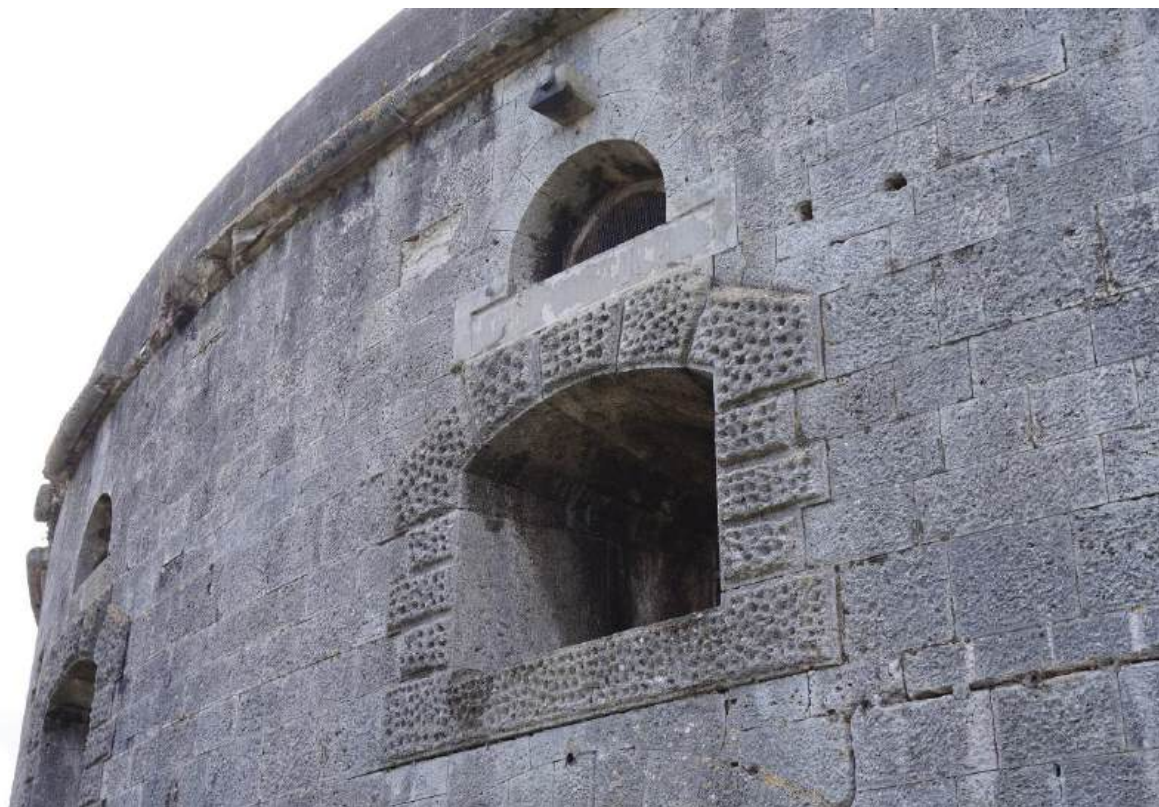
SI. 7.244. Ambrazura i polukružni otvor za ventilaciju kazamata na katu.
