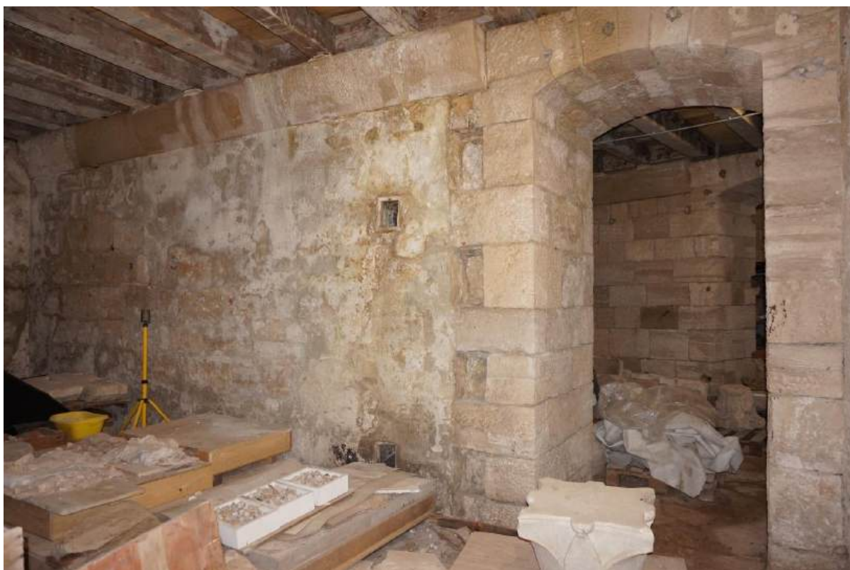
Sl. 7.11. Prizemlje, prostorija 20. Pogled na zid između prostorija 20 i 19.
