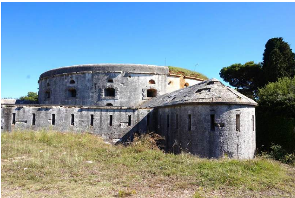
Sl. 7.198. Pogled na utvrdu i zapadni kaponir sa zapada.
