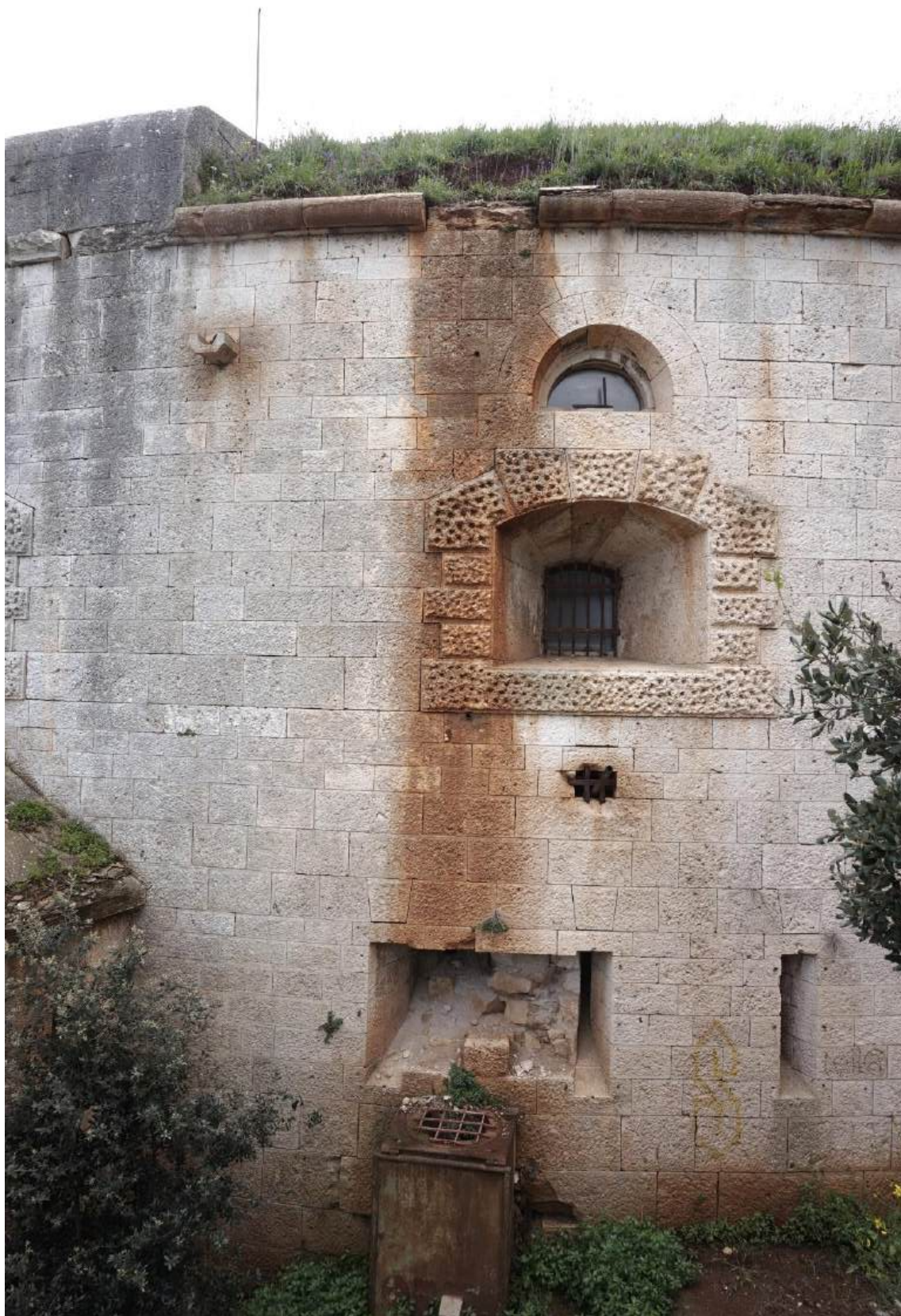
Sl. 7.203. Pogled na sjeverozapadno pročelje. Kat kazamat br. 17, prizemlje kazamat br. 04.
