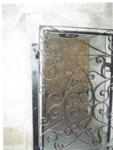
Sl. 80, 81 Vrata prema prostoriji 22 i detalj nosača montiran u kameni dovratnik premazan cementnim mortom.
