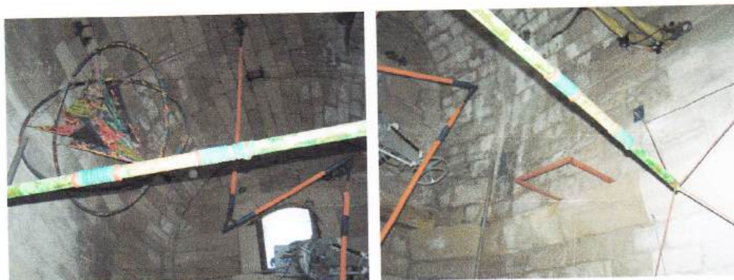
Sl. 113, 114 Nosači i cijevi ugrađeni u kamene blokove.
