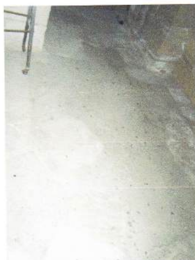
Sl. 82 Cementne zakrpe poda.
