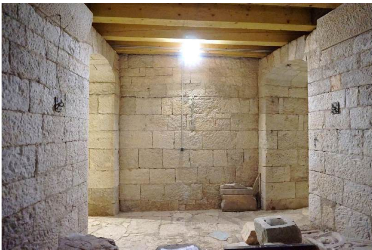
Sl. 7.45. Prizemlje, prostorija 9. Pogled na unutarnji zid.
