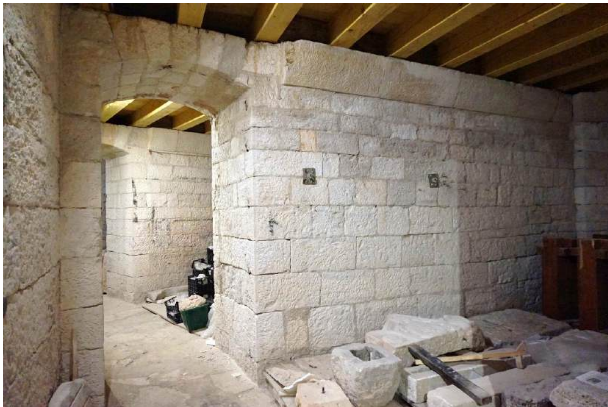
Sl. 7.46. Prizemlje, prostorija 8. Pogled na zid između prostorija 8 i 9.
