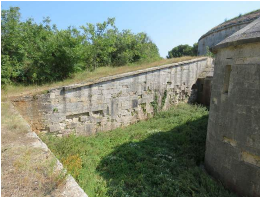
Sl. 37 Zid koji podržava zemljani nasip izvan utvrde, primjetna je velika količina blokova ispucanog, izljuskanog i izgubljenog završnog sloja.
