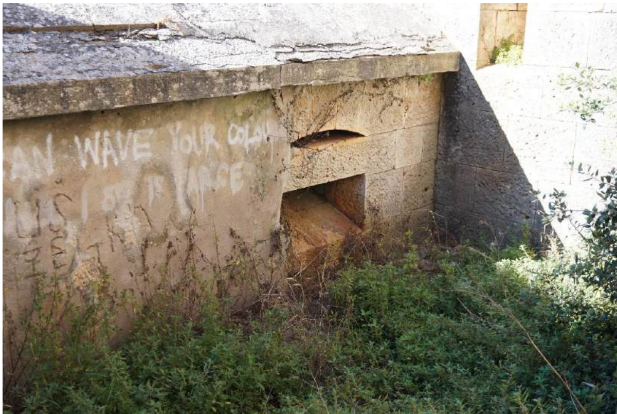
SI. 7.228. Galerija na spoju zapadnog kaponira i zapadne galerije u kontraeskarpi. Južno pročelje s horizontalnim ambrazurama.
