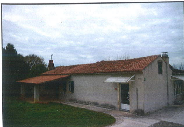
GRAĐEVINA SA OKUĆNICOM
